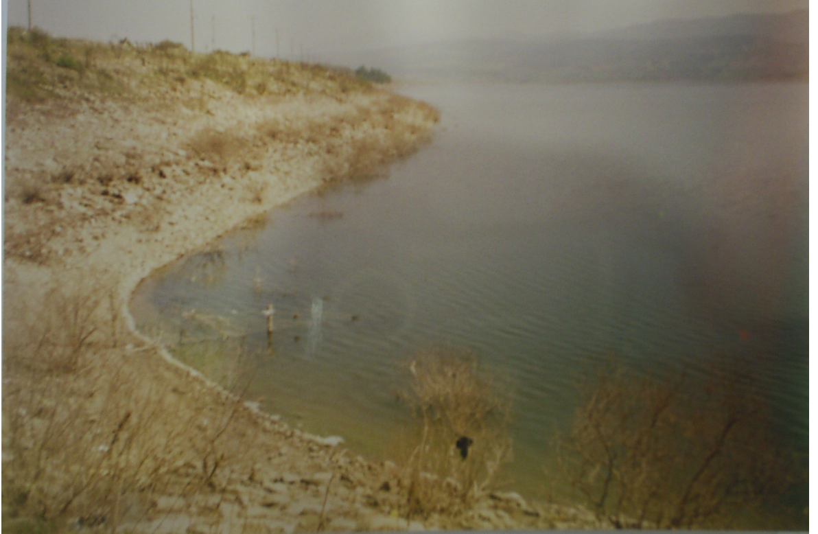
Şekil 3.1.1.2.1: Avşar barajı istasyon 1
