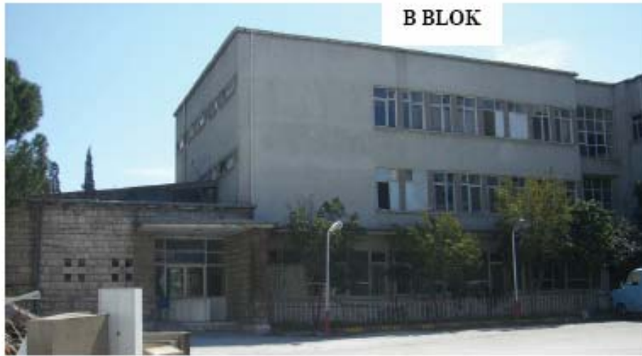
Fotoğraf 2.9. İncelenen Bina Görünüşü
