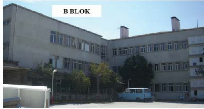
Fotoğraf 2.8. İncelenen Bina Görünüşü
