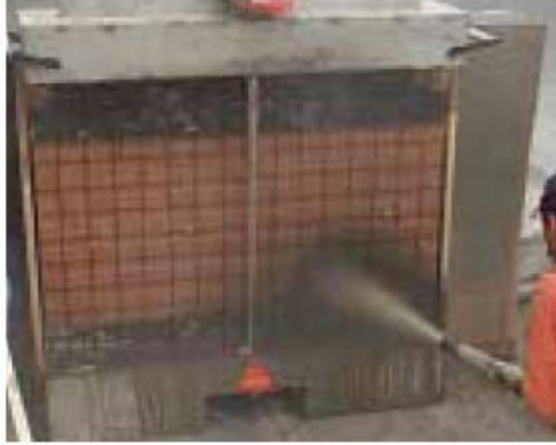
Fotoğraf 2.2. Deney numunesi için shotcrete uygulaması (ElGawady 2004) [6]
