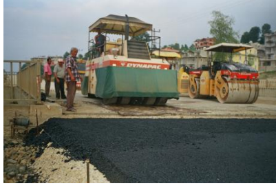
Şekil 3.7. Karışımın Sıkıştırılma İşlemi
