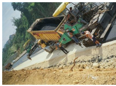
Şekil 3.5. Kamyonların Finişere Boşaltılması ve Serim
