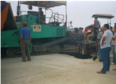
Şekil 3.4. Finişerin Oturtulması
