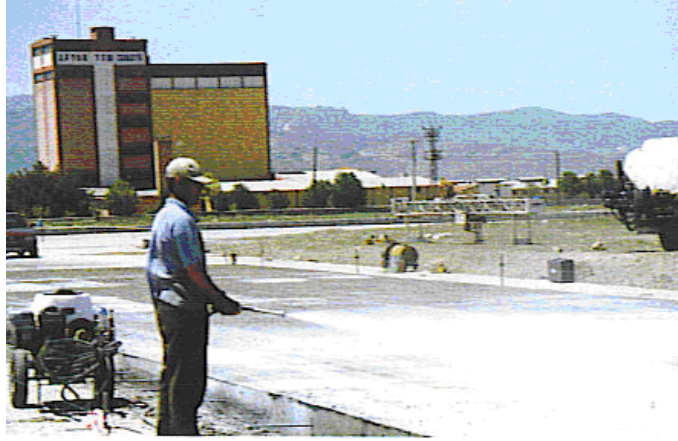
Şekil 4.7. Beton Dökümü Sonrasında Kür İşlemi
