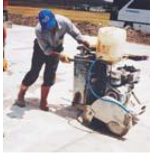
Şekil 4.6. Beton Dökümünden Sonra Derzlerin Kesimi (Yeğinoğlu, 2009)
