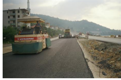
Şekil 3.8. Silindiraj
