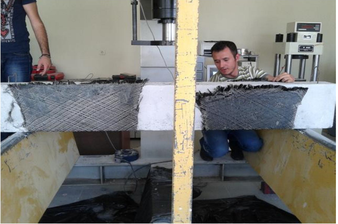
Şekil 6.7. GK2 kirişinin Karbon takviyeli kumaş lifleriyle sarılıp güçlendirilmesi
