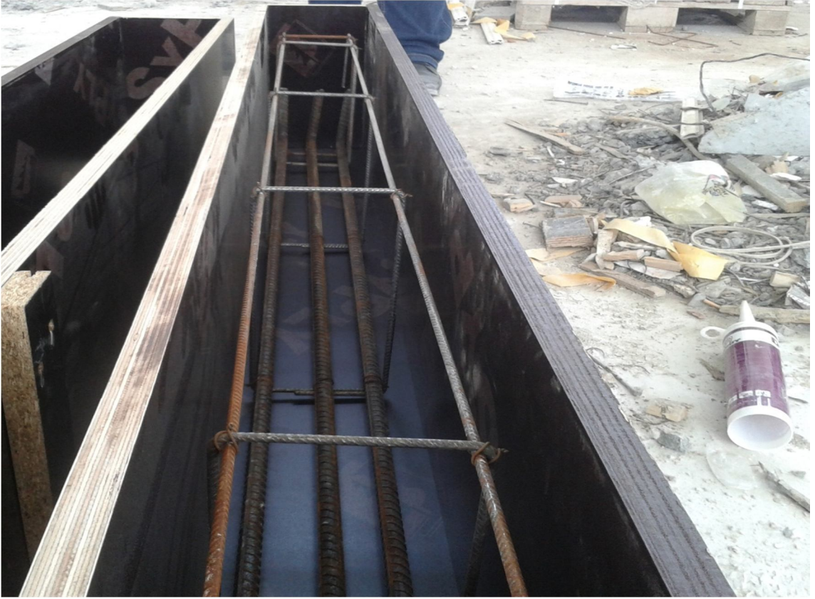
Şekil 4.2. Deney elemanlarının kalıba yerleştirilmesi
