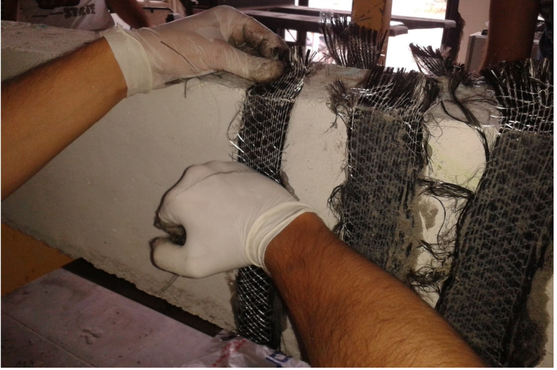
Şekil 6.9. GK3 kirişinin Karbon takviyeli kumaş lifleriyle sarılıp güçlendirilmesi
