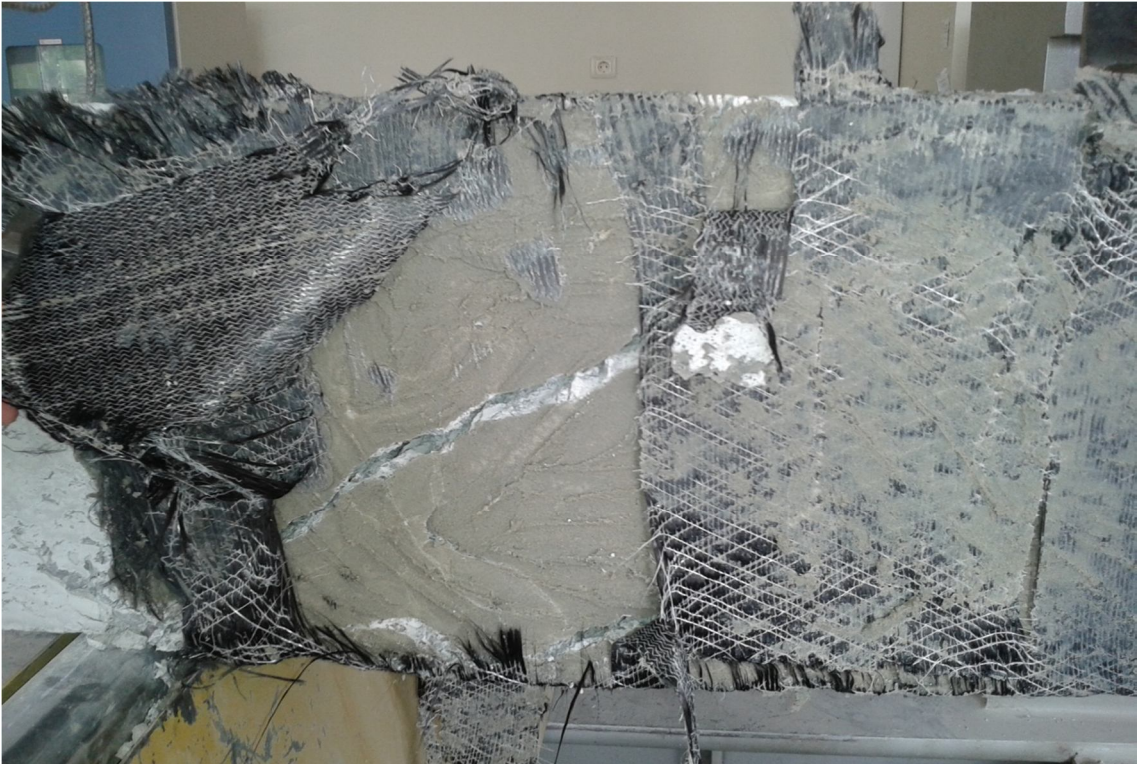
Şekil 8.10. GK2 kirişinde göçme sonucu oluşan kesme çatlakları
