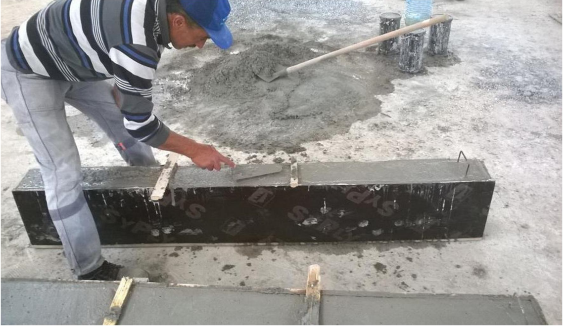
Şekil 4.3. Deney elemanlarının beton dökümü
