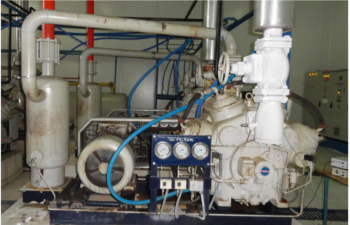
Şekil 2.8 Tesiste Bulunan 110 kW Gücünde, 6 WB Serisi Yüksek Basınç Kompresörü
