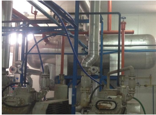
Şekil 2.11 Alçak Basınç Yoğuşma Tankı
