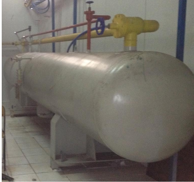
Şekil 2.10 Soğutma Çevriminde Yer Alan Likit Tankının Perspektif Görüntüsü
