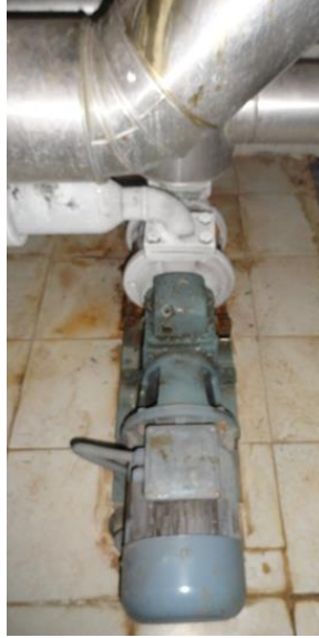
Şekil 2.15 10 kW Gücündeki Yüksek Basınç Amonyak Pompası
