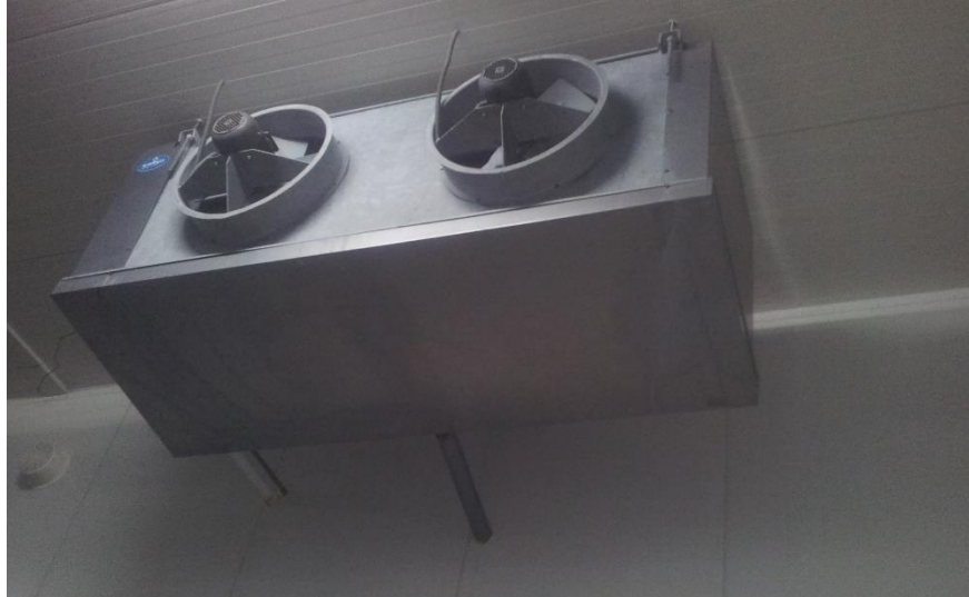
Şekil 2.14 Sođuk Odalarda Yer Alan Çift Fanlı Evaporatör
