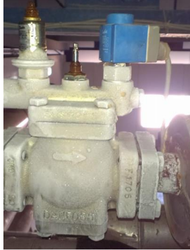
Şekil 2.16 PM1 Serisi Regülasyon Valfi ve Solenoid Valf
