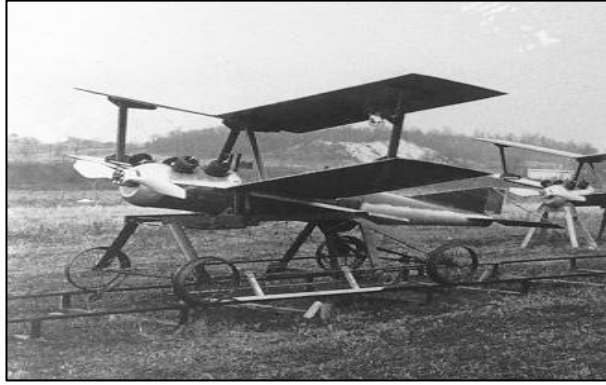
Şekil 1.3. Kettering Hava Torpidosu
