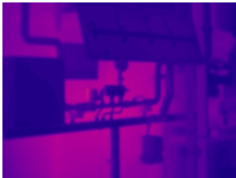
Şekil 4.3 AKF Sağ Yüzey Termal Kamera Görüntüsü
