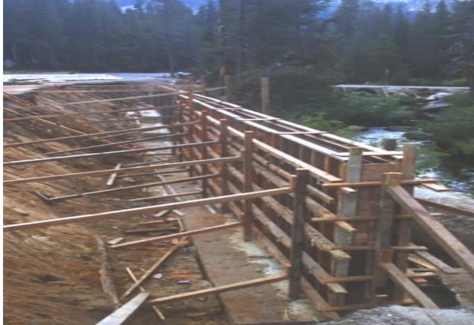
Şekil 1.1. Bir betonarme istinat duvarı
