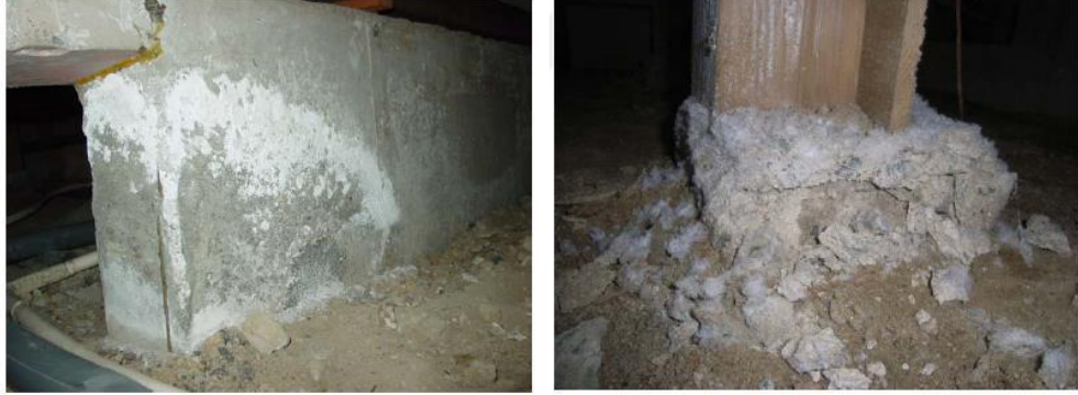
Şekil 2.4. Tuz kristalizasyonuna maruz kalındığında betonarme hasar [177]
