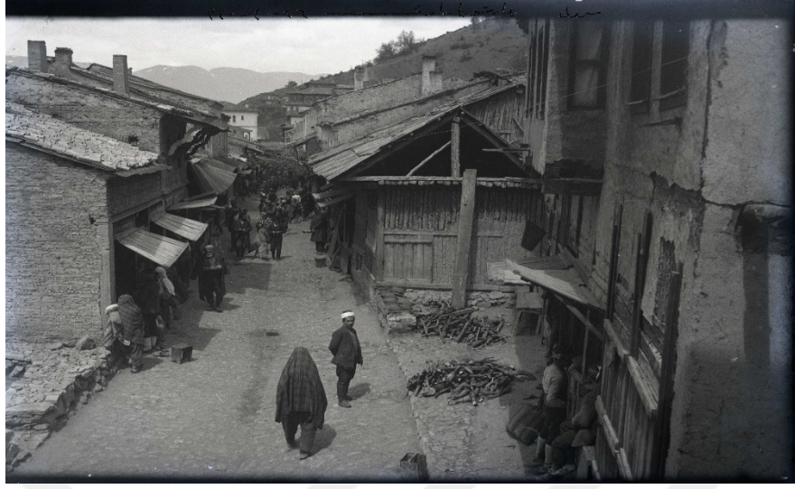
Fotoğraf 1.5: (üstteki yazı) Mudurnu Demirciler-Bakırcılar Çarşısı'nda alışveriş yapanlar 26 Nisan 1924, Bengüboz Fotoğrafları Mudurnu kent arşivi.
