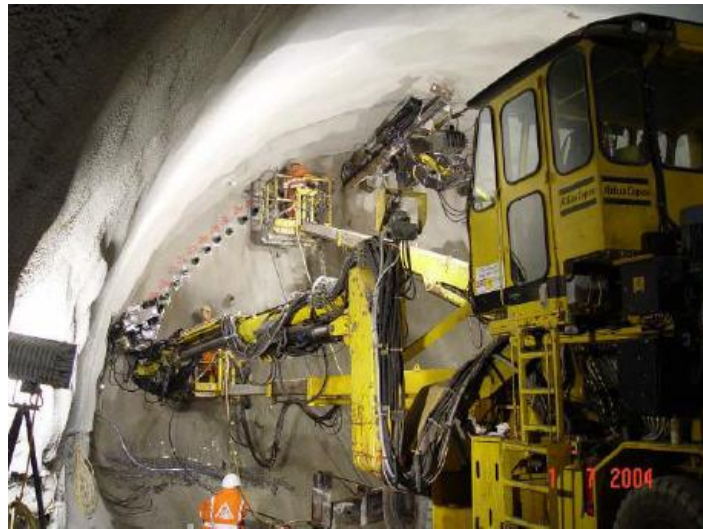
Şekil 2.42 Delici jumbonun kullanılmasıyla şemsiye kemer borularının hazırlanması (Gamsjäger and Scholz 2009).
