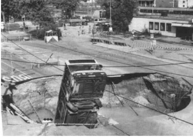
Şekil 2.9 Bir sığ tünelde yeryüzüne ulaşan bir çökme sonucu gerçekleşen kaza (Kolymbas 2005).
