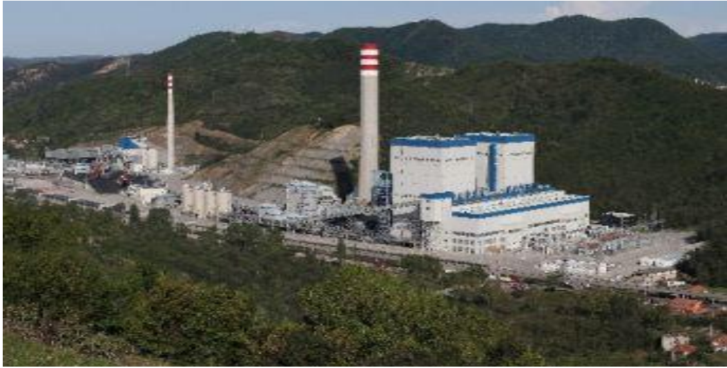
Şekil 2.2 Eren Enerji Termik Santralinin Genel Görünümü (URL-2 2013).
