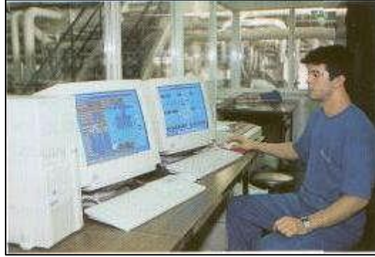
Şekil 5.6 Merkezi kontrol odası.
