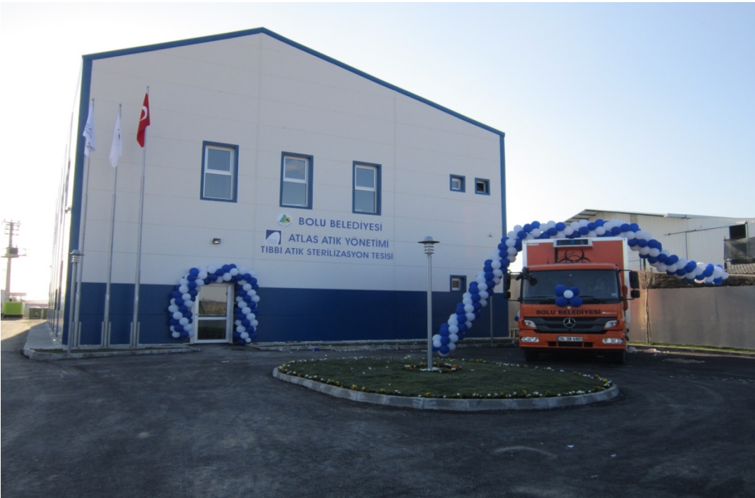
Resim 4. Tıbbi atık sterilizasyon tesisi
