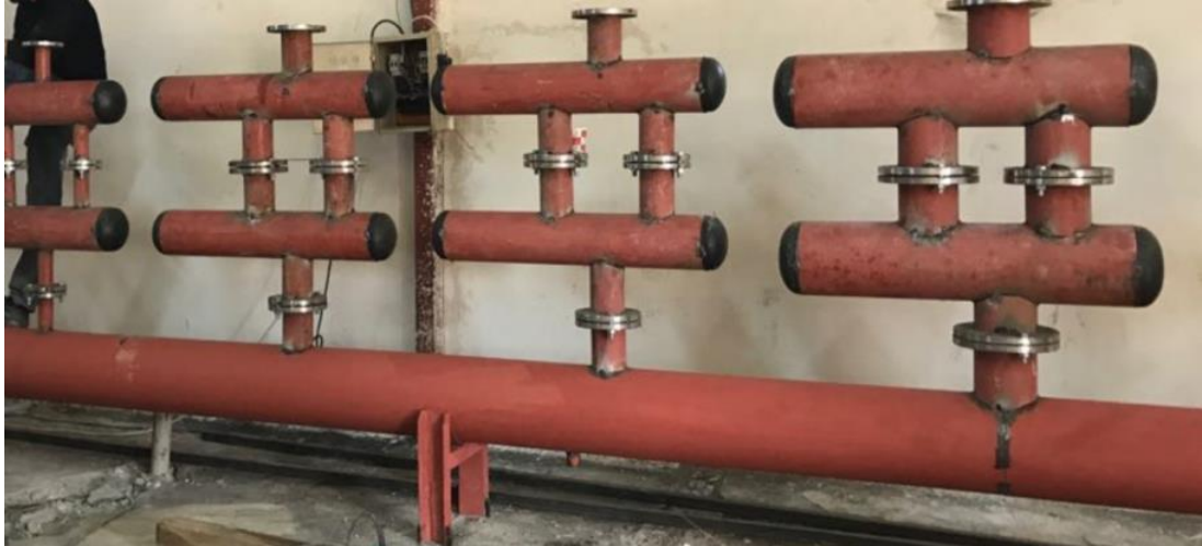
Şekil 4.3. Otel ana ısıtma kollektörü
