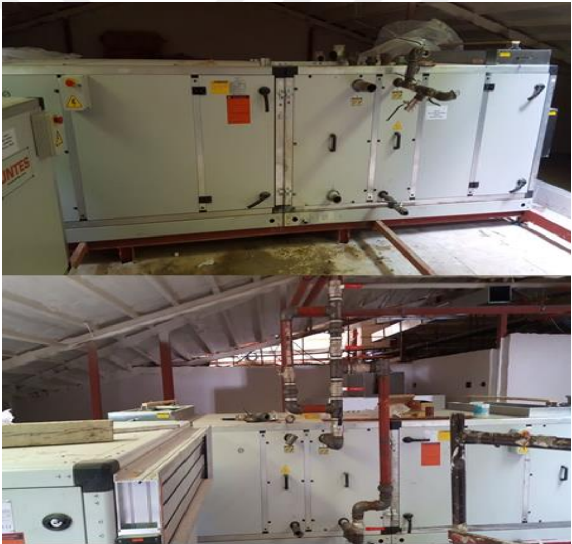
řekil 3.102. Otelde kullanılan klima santralleri
