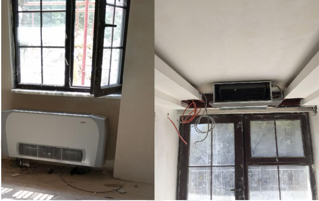
Şekil 4.6. Otelde kullanılan tavan tipi ve yer tipi fan coil örnekleri
