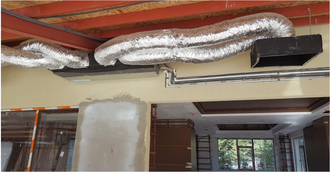
Şekil 4.9. Örnek bir mahalde havalandırma kanalı menfez bağlantısı
