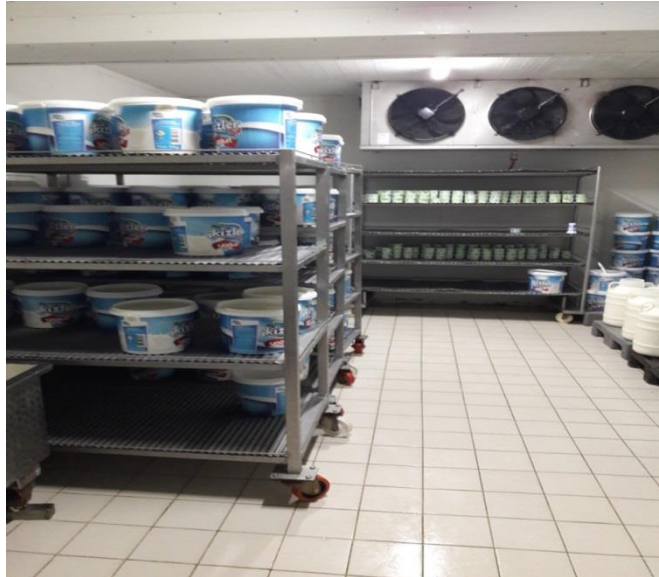
Şekil 2.12. Yoğurtların soğuk havada depolanması (İkizler Süt Fabrikası’ndan)
