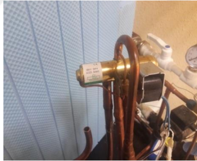
Şekil 3.8. 4 Yollu Selenoid Yön Kontrol Valfi
