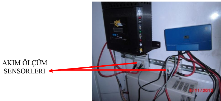
Şekil A.4 Rüzgar ve Güneş MPPT çıkışı akım ölçüm noktaları.
