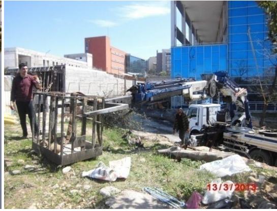
Şekil B.2 Türbin bakımı için gelen vinç.
