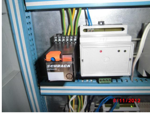
Şekil A.3 Akü-yük ve alternatif besleme seçimini yapan role ve ölçüm bağlantı kutusu.
