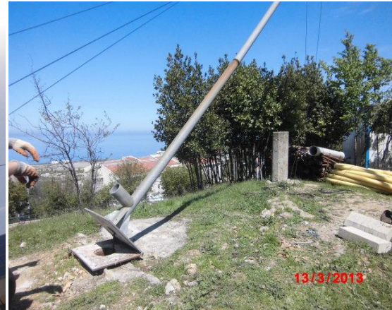
Şekil B.4 Rüzgâr türbininin indirilmesi.
