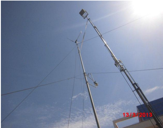
Şekil B.3 Rüzgâr türbininin indirilmesi.
