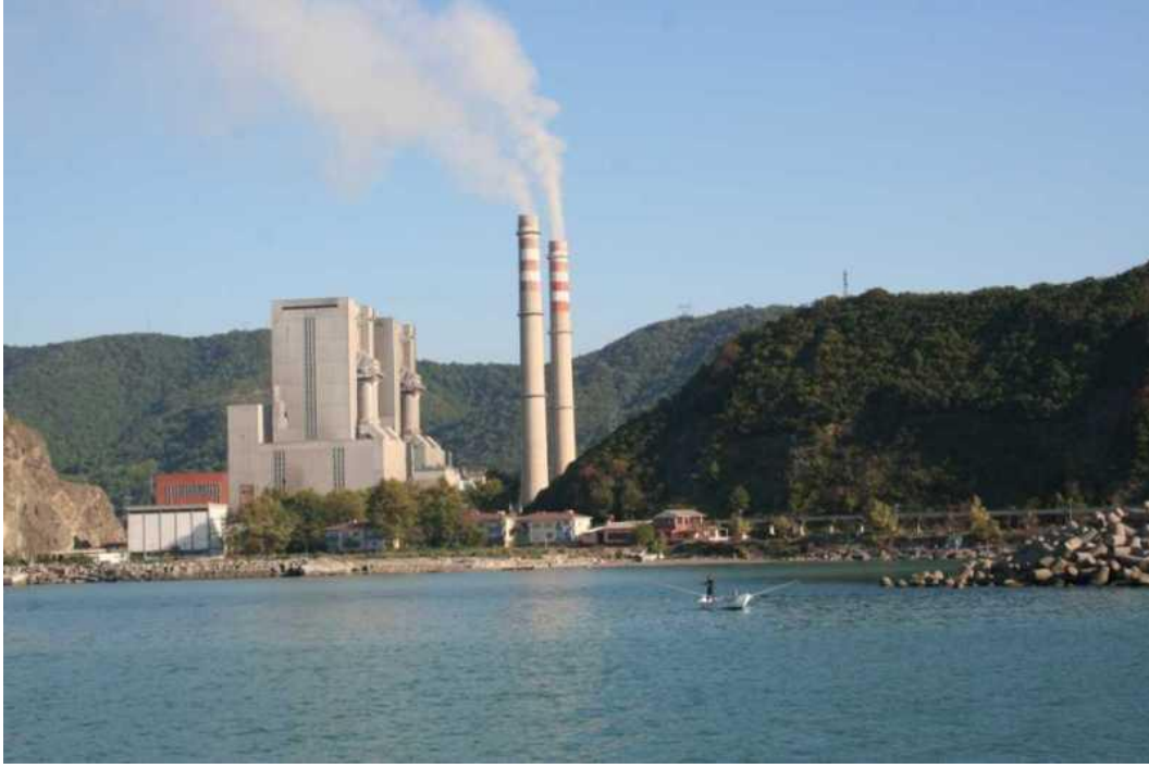
Şekil 3.1 Çatalağzı Termik Elektrik Santrali (ÇATES).
