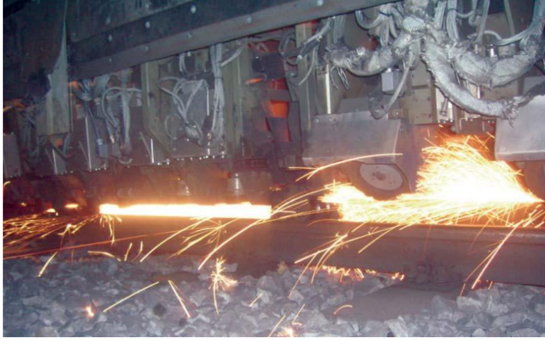
Şekil 5.9 Ray taşlama araçları ile taşlama (Candemir 2010).
