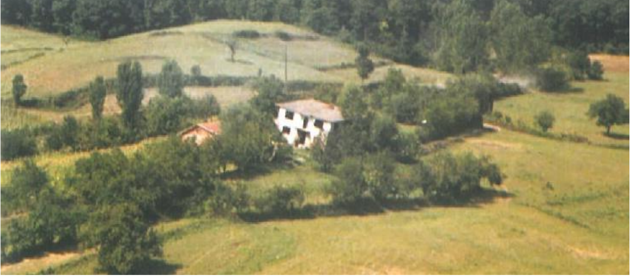
Şekil 4.22 Kayma sonucu evlerin eğilmesi (Duman vd. 2005).
