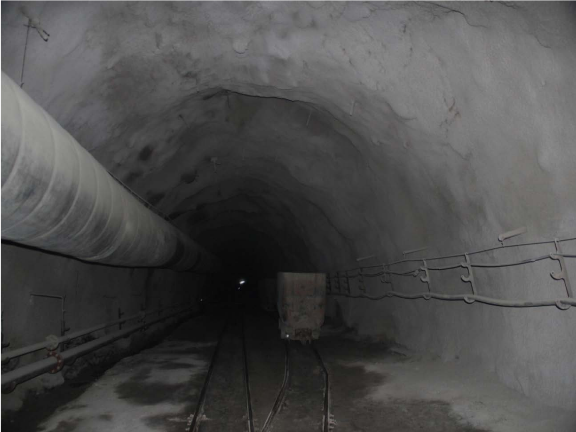
Şekil 4.10 Püskürtme beton tahkimatlı ana galeri görünümü.
