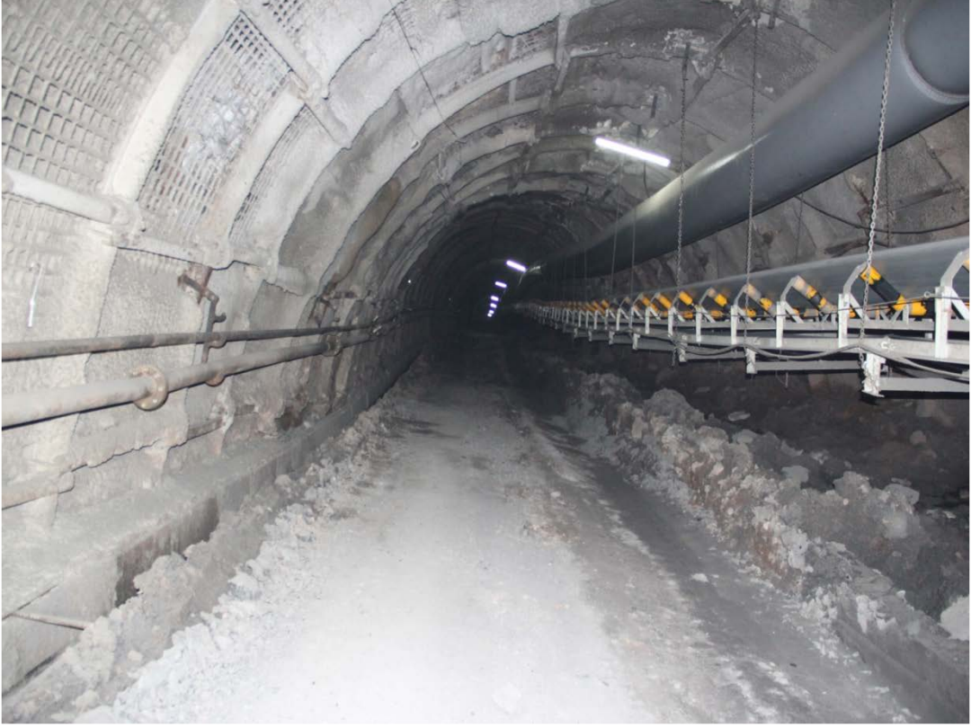
Şekil 4.11 TH-bağ takviyeli püskürtme beton tahkimatli ana galeri görünümü.
