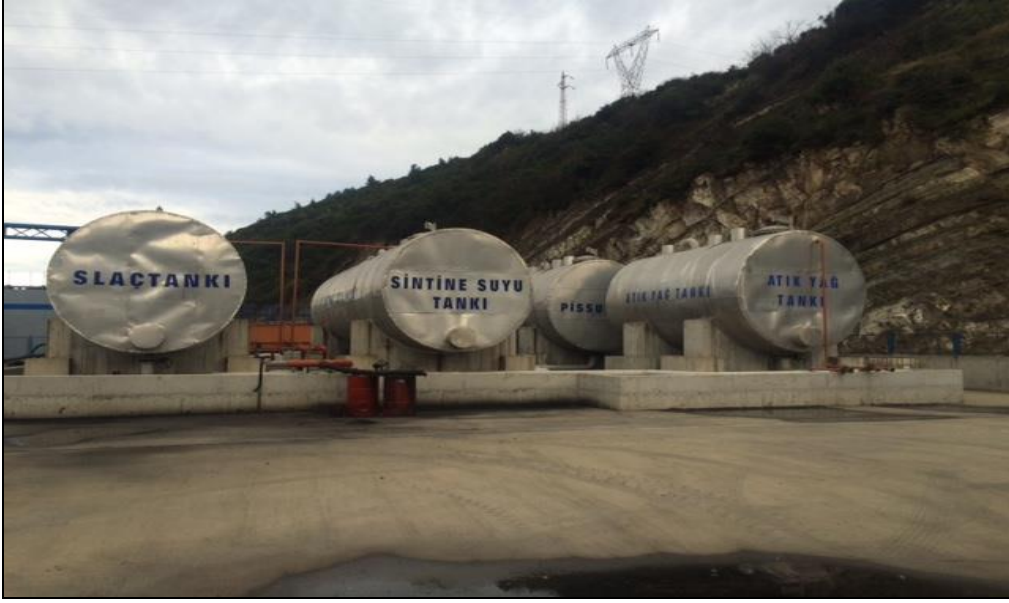
Şekil 5.11. Eren Limanı Atık Kabul Tesisi Genel Görünüm.
