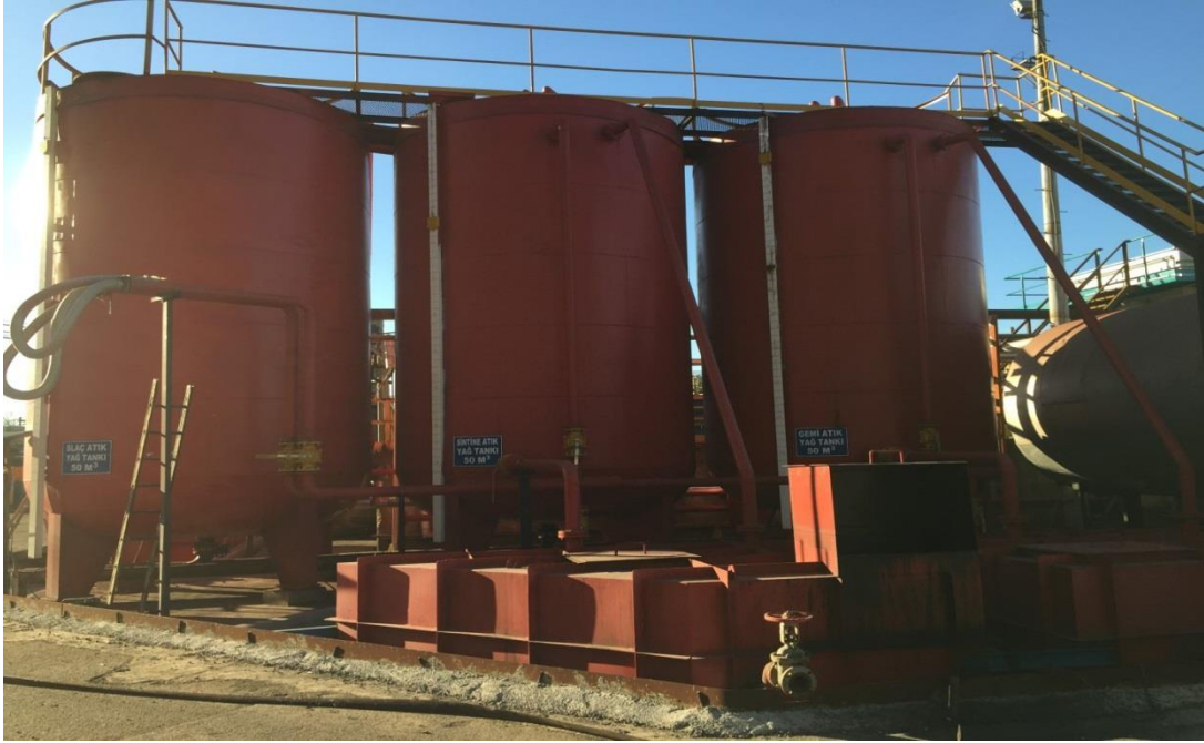
Şekil 5.5. Erdemir Limanı Atık Kabul Tesisi Genel Görünümü.
