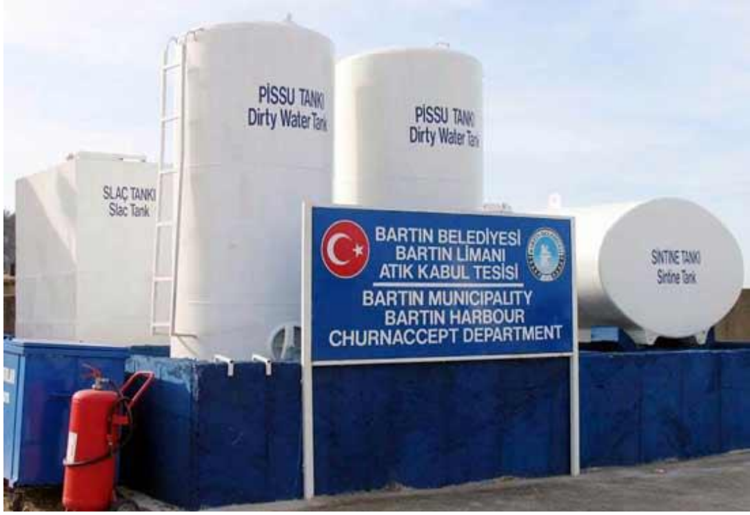
Şekil 5.19. Bartın Limanı Atık Kabul Tesisi Genel Görünümü.
