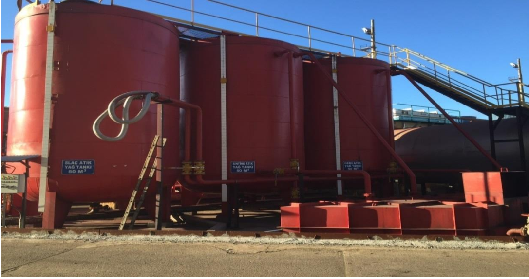
Şekil 5.4. Erdemir Limanı Atık Kabul Tesisi Genel Görünümü.
