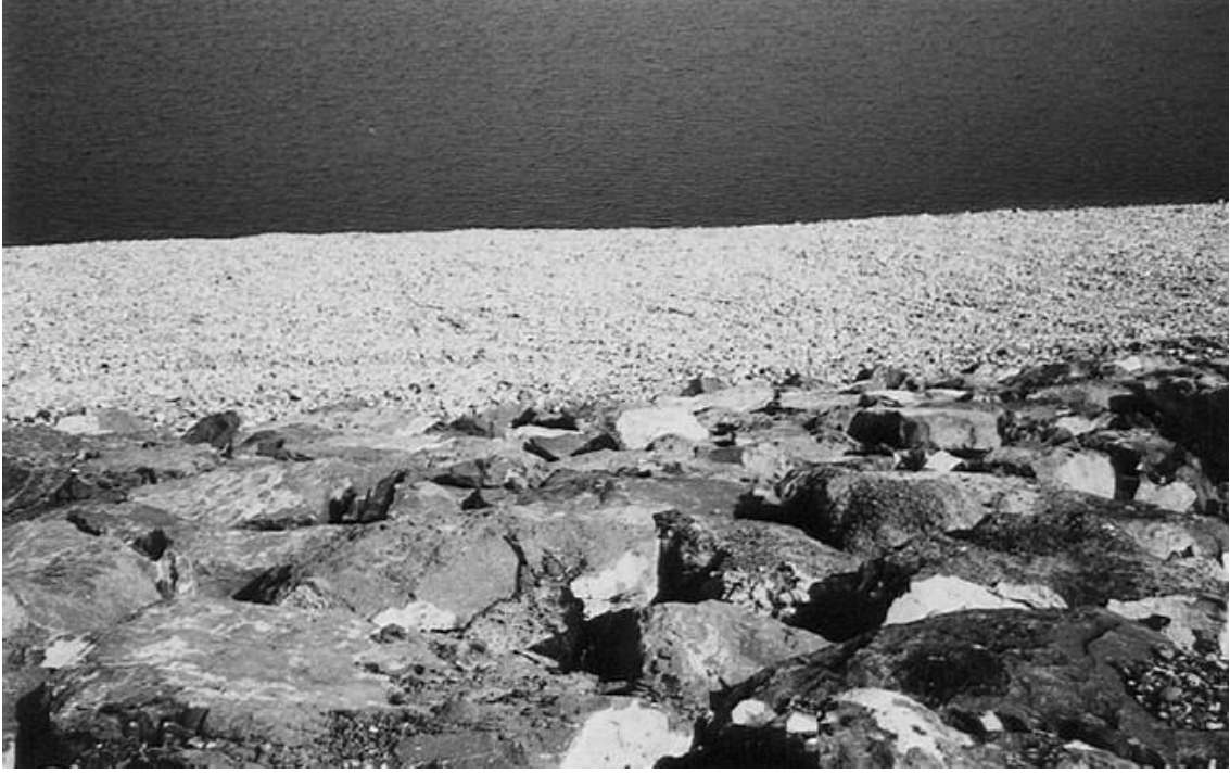
Şekil 1.9 Memba kısmından parçalanmış bazalt malzemesinin görüntüsü [28].
