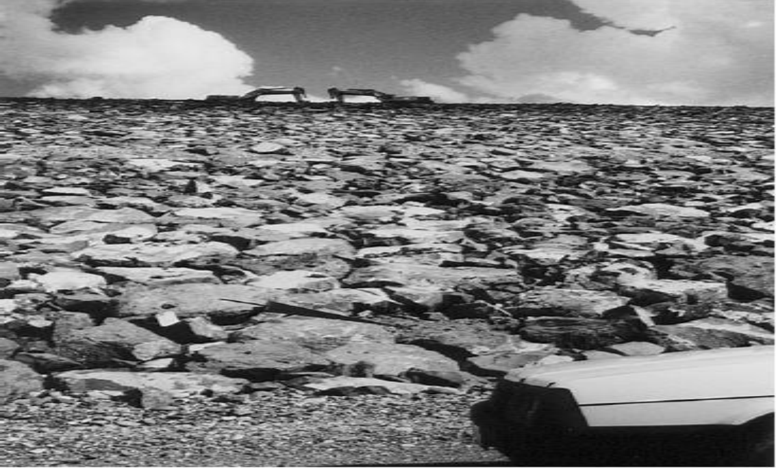
Şekil 1.10 Mansap kısmından parçalanmış bazalt malzemesinin görüntüsü [28].
