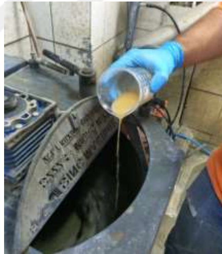
Şekil 3.35 Taze beton karışımı içerisine katkı maddesi ilavesi
