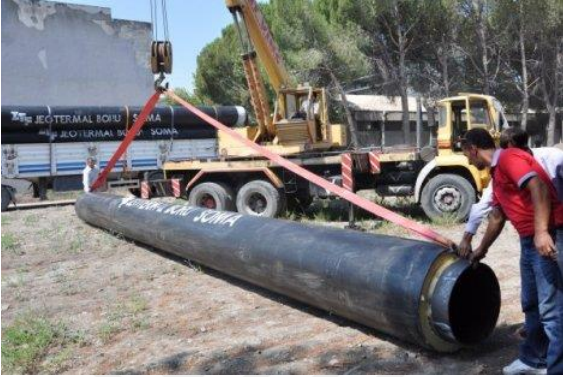
Şekil 4.18 Önizolasyonlu boru montajı vinç çalışmaları [42].
