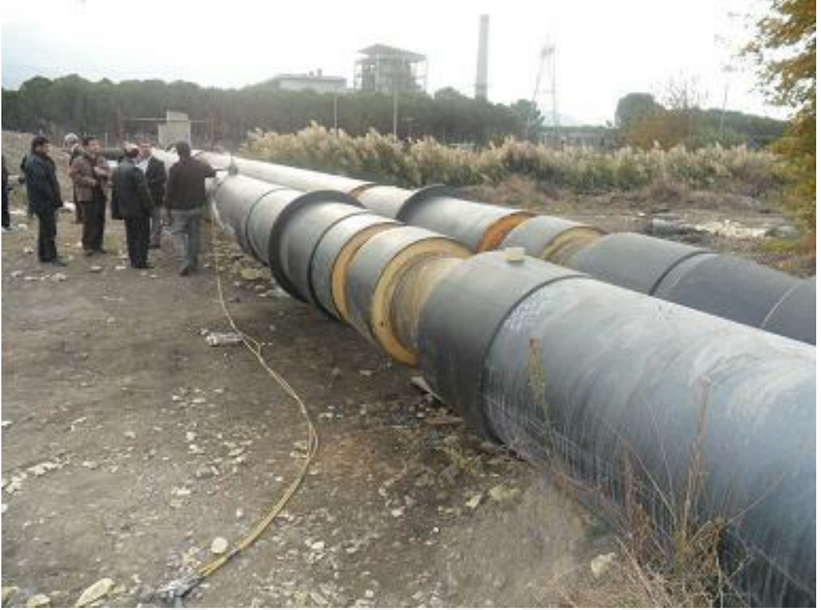
Şekil 4.14 Önizolasyonlu boru uygulaması [42].
