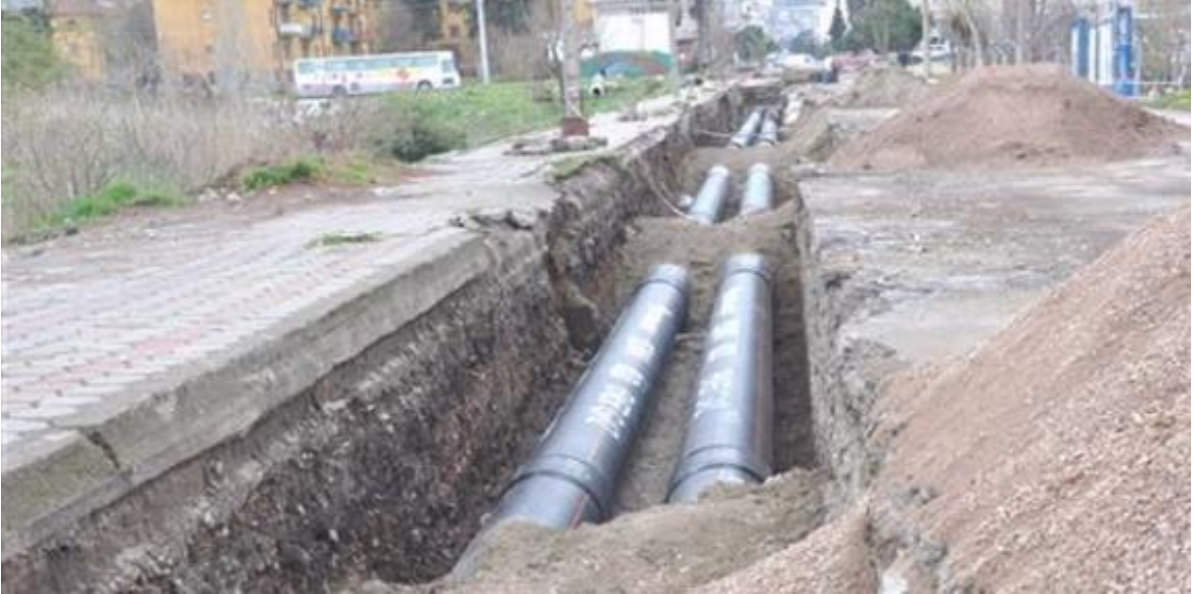
Şekil 4.15 Önizolasyonlu boru uygulaması [43].
