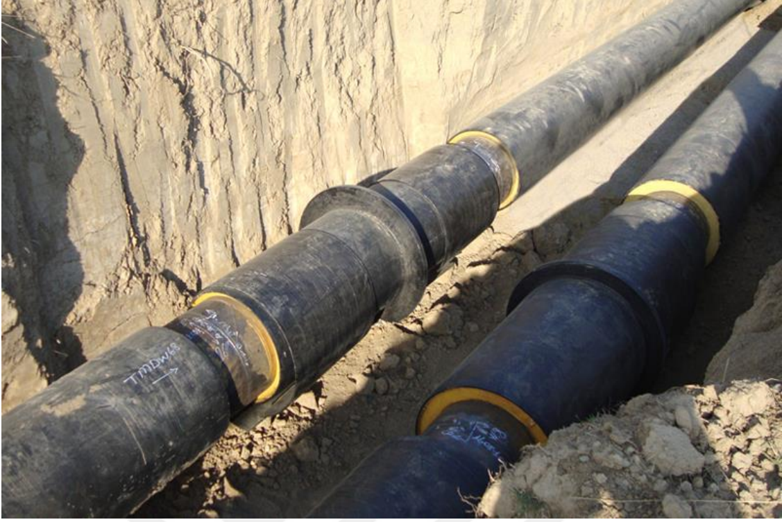
Şekil 4.16 Önizolasyonlu boru birleştirme uygulaması [44].
