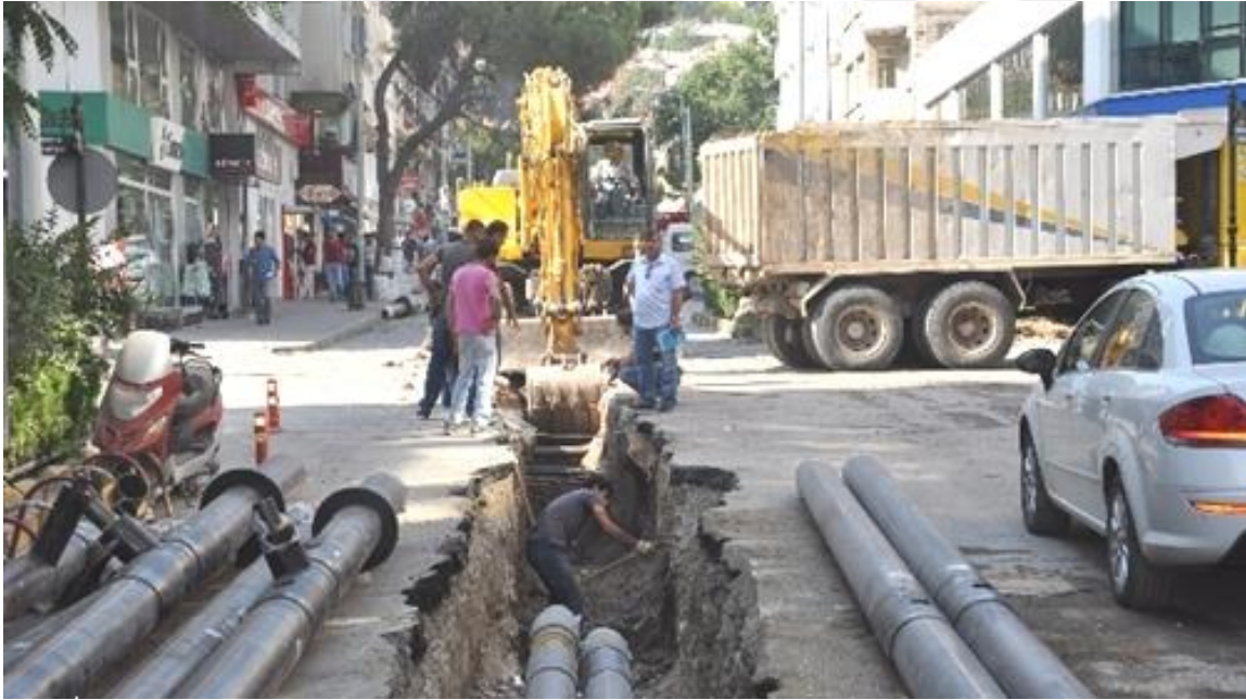
Şekil 4.17 Önizolasyonlu boru kazı ve montaj uygulaması [45].
