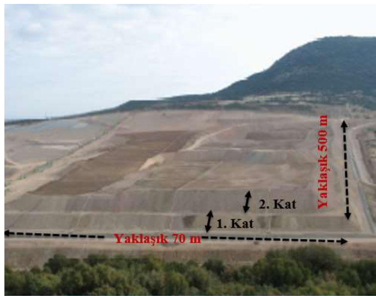
Şekil 3.3 Uşak Kışladağ Altın Madeni, yığın görüntüsü (AMD 2011).
