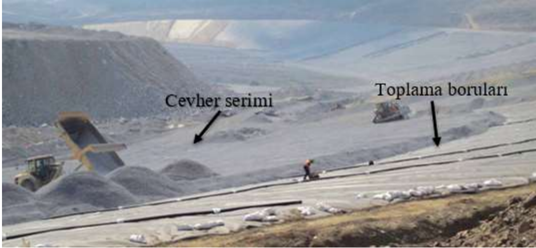
Şekil 5.4 Kamyon ile cevher serimi (URL-5 2018).
