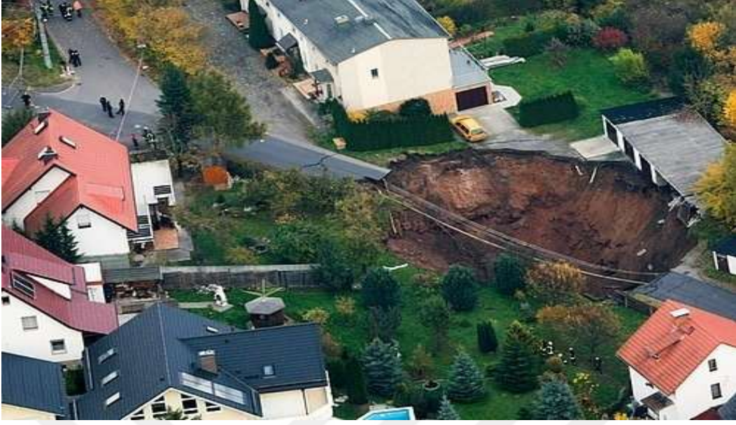
Şekil 5.2 Tasmandan kaynaklı oluşan hasar (URL-9)
