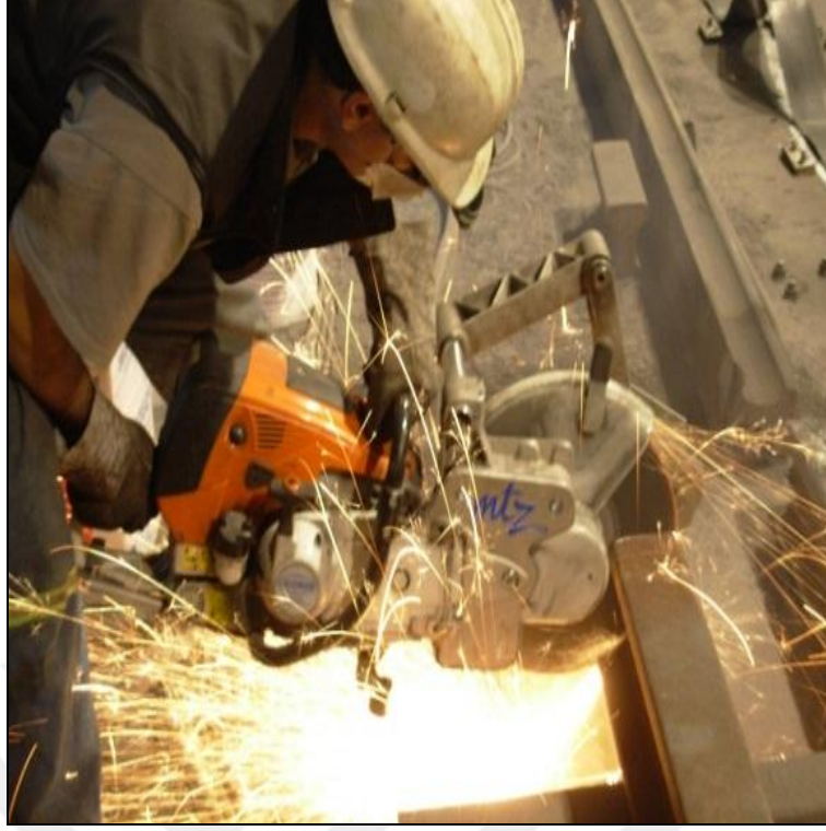
Şekil 2.13 Ray Kafalarının Kesilmesi.
