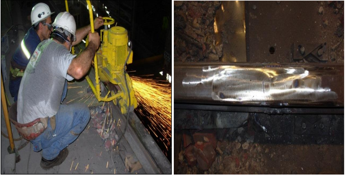
Şekil 2.23 Ray Yüzeyinin Taşlanması (a) ve (b).
