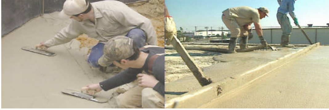
Şekil 2.8. Vermikülitin Hafif Beton Uygulaması [37]
