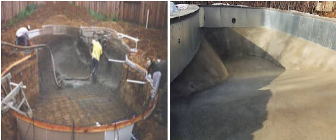
Şekil 2.13. Vermikülitin Su Yalıtımı Uygulaması [37]
