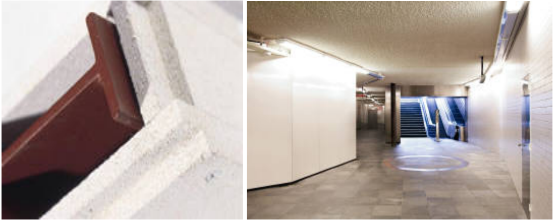
Şekil 2.11. Vermikülitin Yangından Koruma Uygulaması [37]
