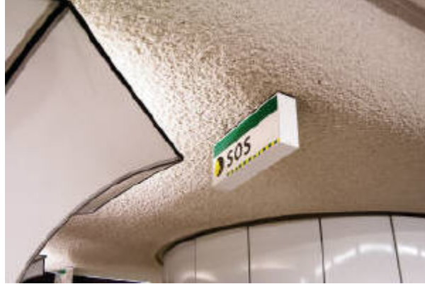
Şekil 2.9. Vermikülitin Sıva Uygulaması [37]
