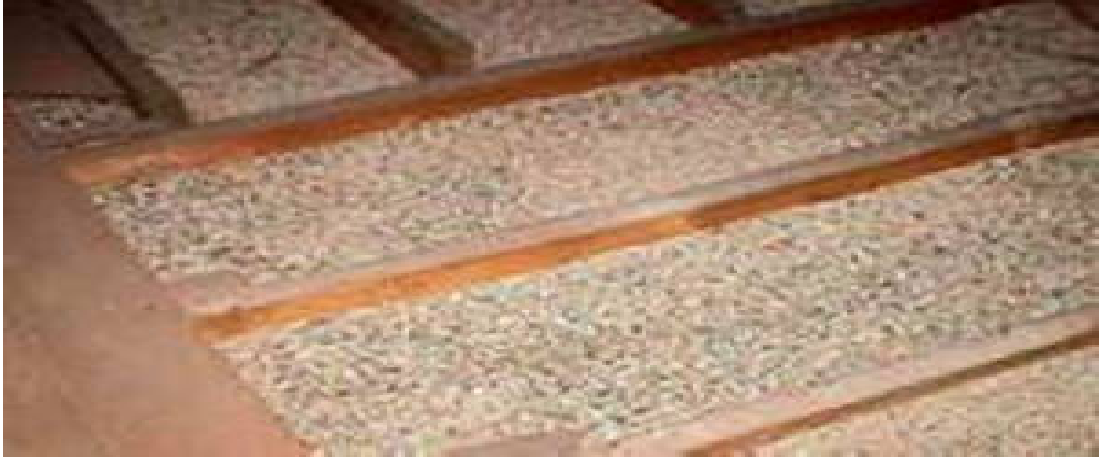
Şekil 2.10. Vermikülitin Çatı Yalıtım Uygulaması [37]
