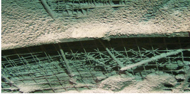
Şekil 2.6. Çelik liflerin tünelde püskürtme betonda kullanımı
