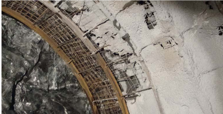
Şekil 2.5. Çelik liflerin tünelde püskürtme betonda kullanımı
