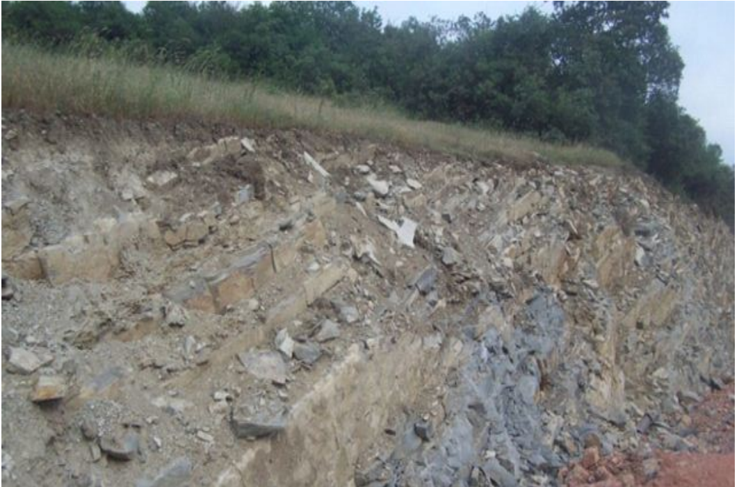
Şekil 2.8. Akveren Formasyonu'nun genel görünümü (Bakış, Kuzey batı yönüdedir).
