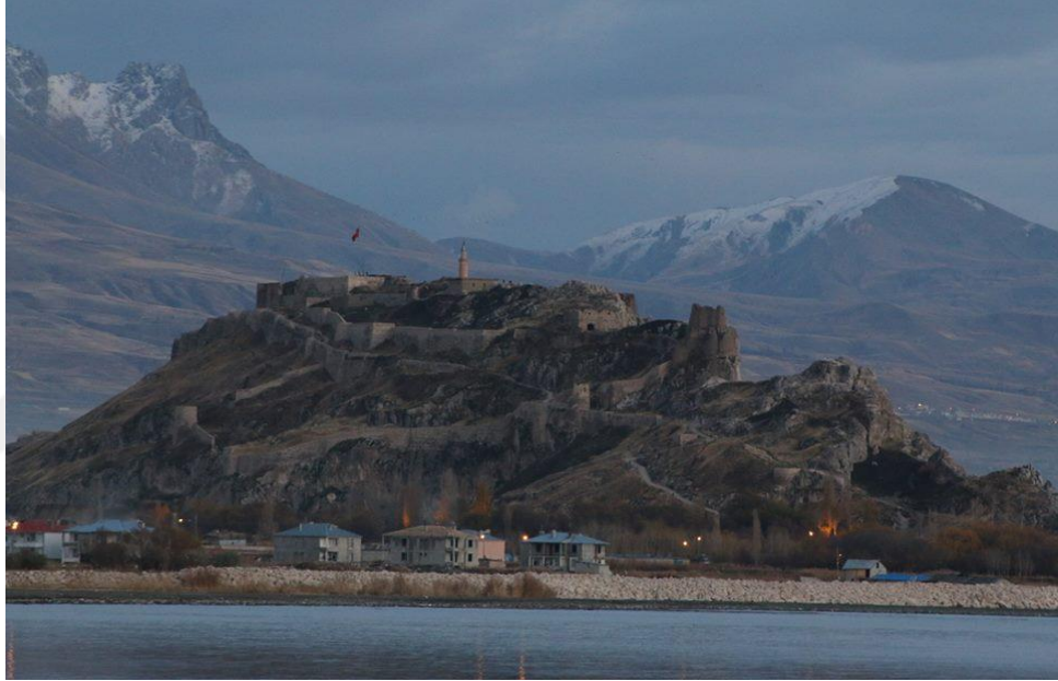
Resim 3.1:Van Kalesi, Kuzeybatıdan Görünüm
