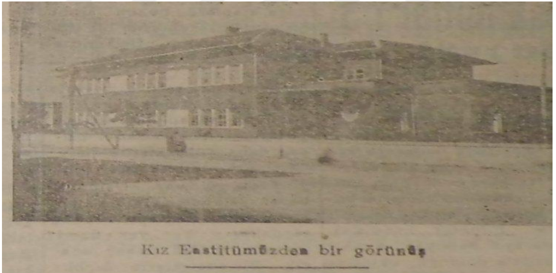
EK 6: Urfa Kız Enstitüsü binası, (Urfa, 12 Eylül 1949)
