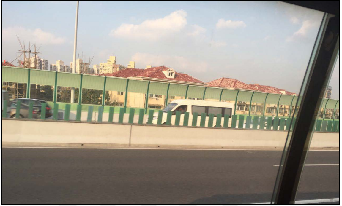
Şekil 5.9: Çin'in Şangay ilinde yer alan otoban çevresine PVC gürültü perdesi uygulaması
