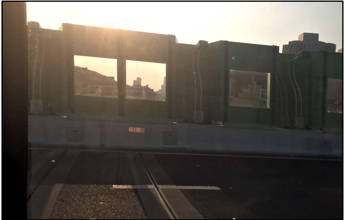
Şekil 5.10: Çin'in Şangay ilinde yer alan anayol çevresine PVC gürültü perdesi uygulaması
