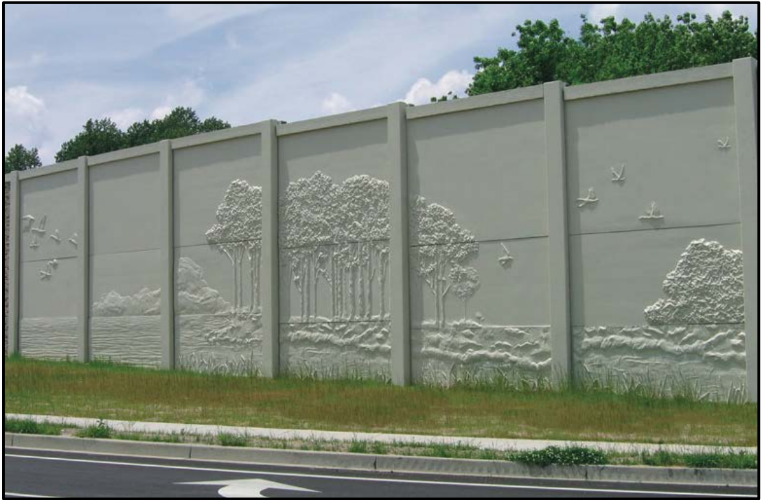
Şekil 5.6: Prekast betondan imal edilmiş bir gürültü perdesi
