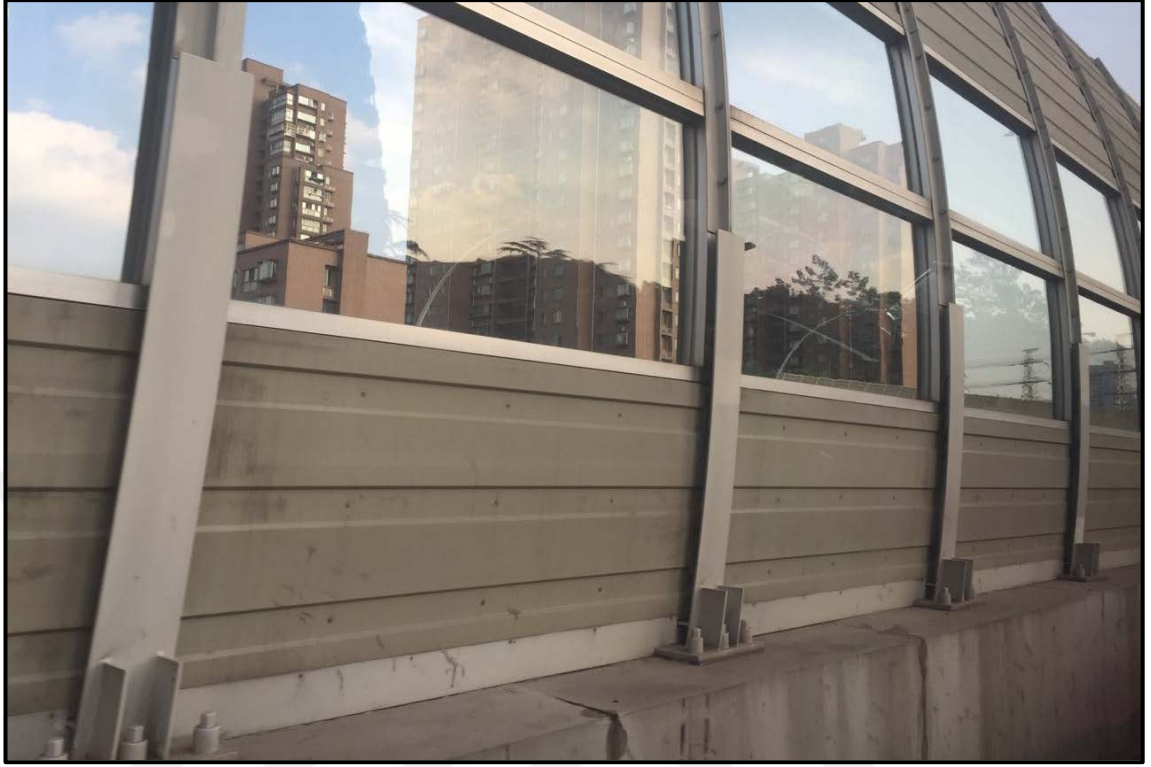
Şekil 5.11: Çin'in Şangay ilinde yer alan anayol çevresine uygulanan metal ve PVC karma kullanımlı gürültü perdesi
