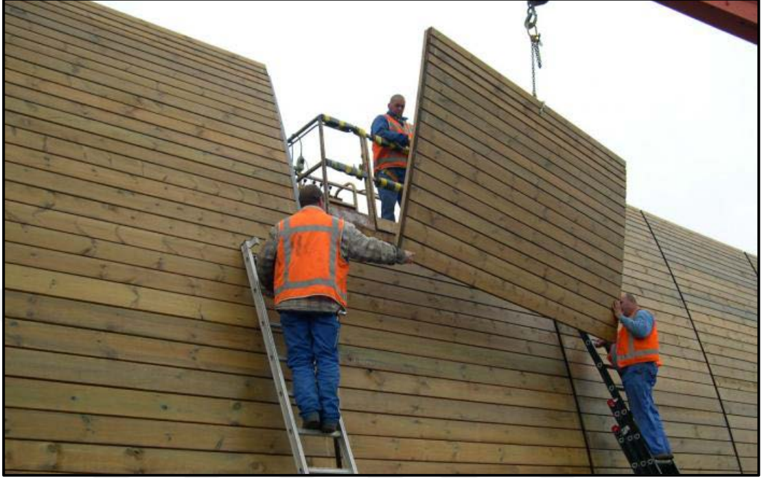
Şekil 5.6: Prekast betondan imal edilmiş bir gürültü perdesi
