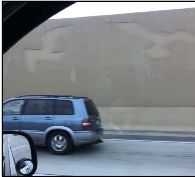
Şekil 5.12: Little Haiti, Miami'de desenli prekast betonarme gürültü bariyeri uygulaması
