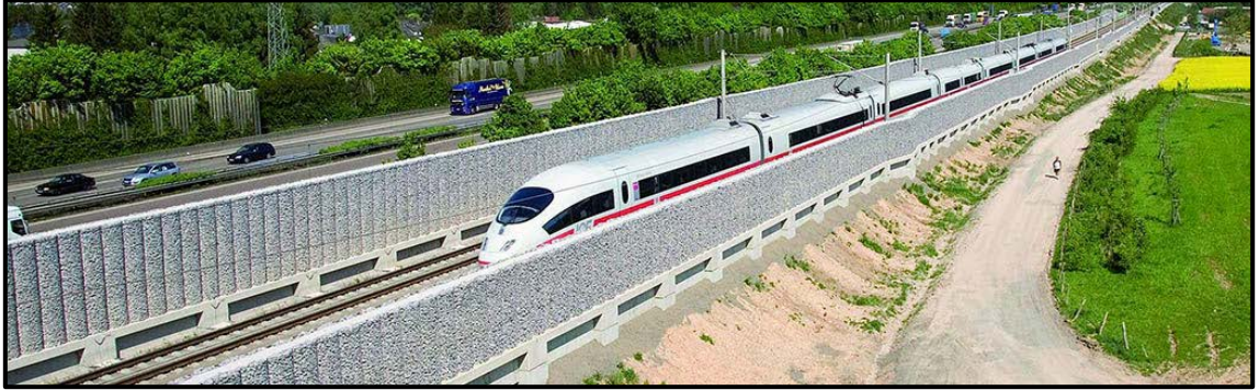
Şekil 5.7: Almanya'da raylı sistem çevresine uygulanan gabyon gürültü perdesi ve otoban kenarına uygulanan beton ve bitkilendirmenin birlikte kullanıldığı gürültü perdesi
