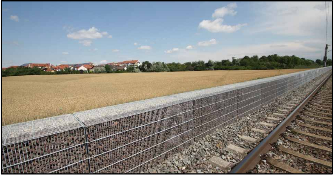
Şekil 5.8: Bingen am Rhein'de şehir dışı raylı sistem çevresine uygulanan kısa, gabyon gürültü perdesi
