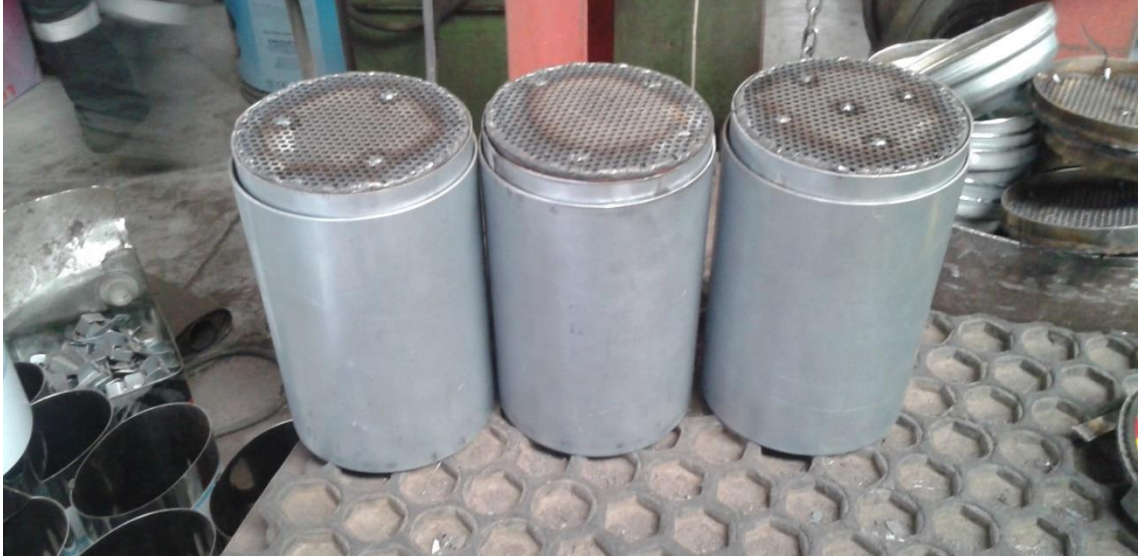
Şekil 3.10. İçerisine perlit, pomza ve perlit-pomza karışımı konulan konvertörlerin ızgara ile kapatılması
