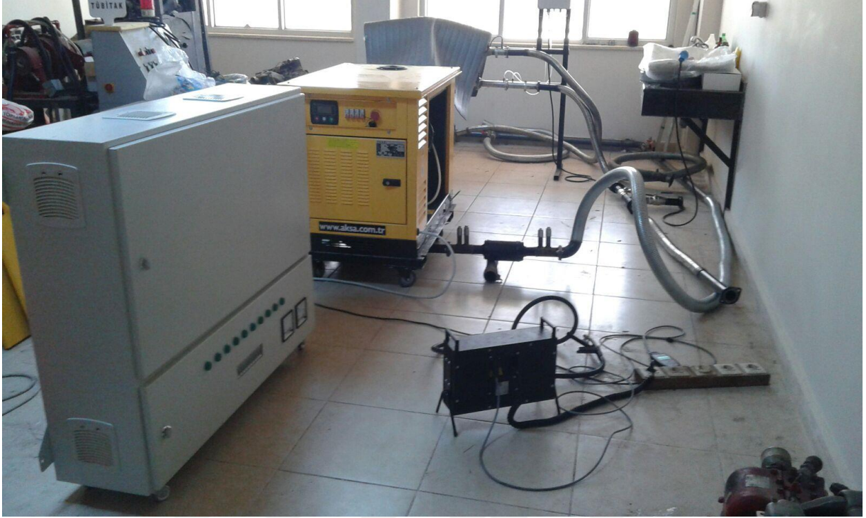
Şekil 3.14. Hazırlanan konvertörlerin dizel motor ünitesine bağlanması
