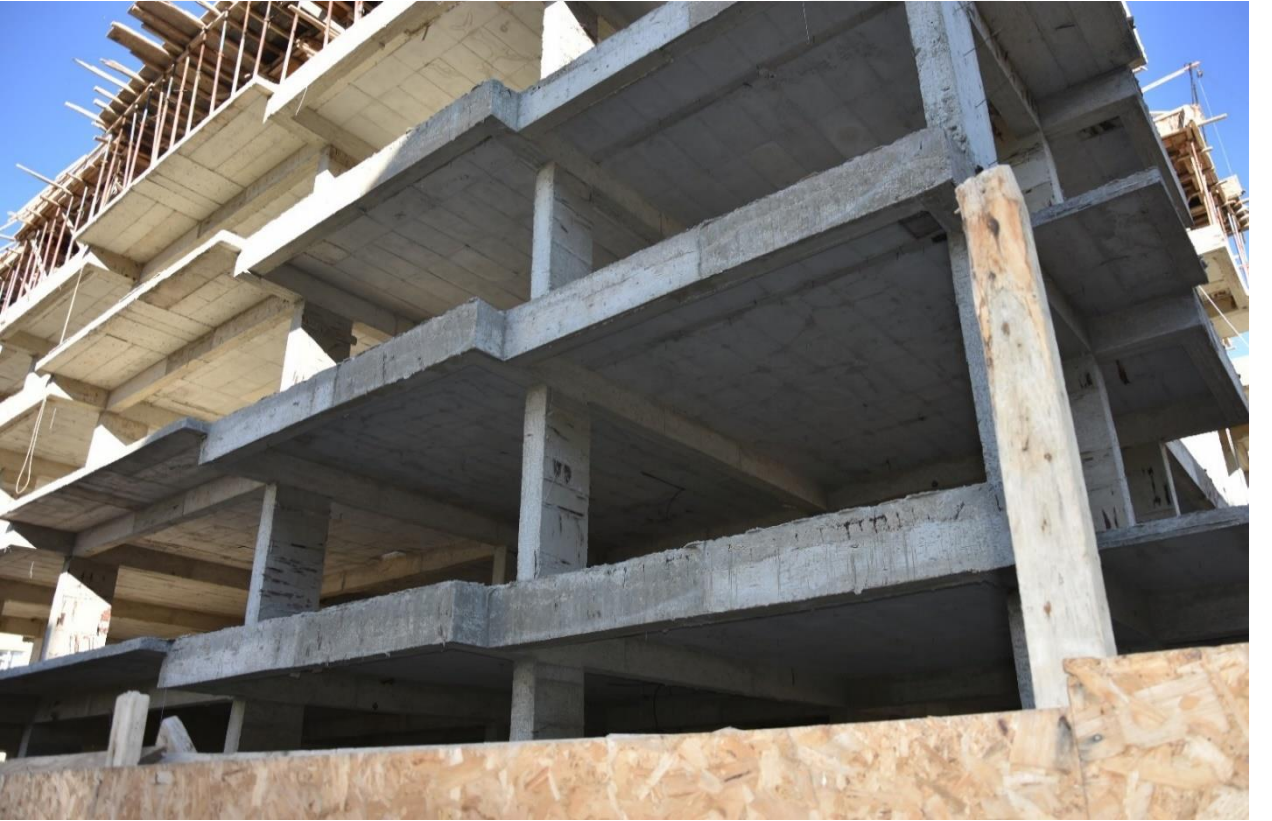
Şekil 1.4. Çıkmalı Yapı-Kiriş Süreksiz
