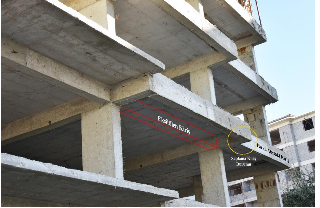
Şekil 1.5. Çıkmalı Yapı-Kiriş Süreksiz
