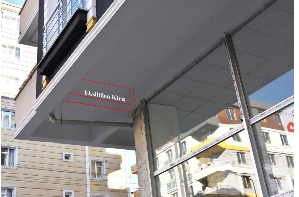
Şekil 1.6. Çıkmalı Yapı-Kiriş Süreksiz
