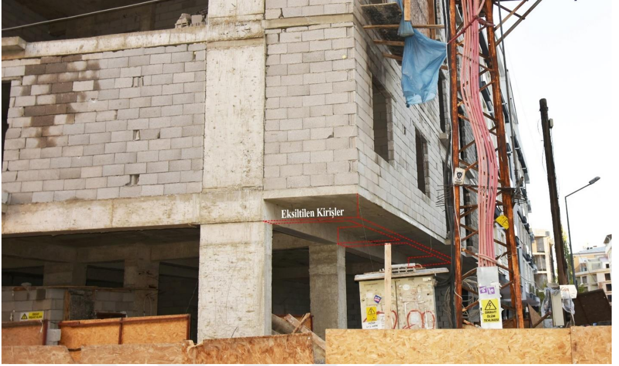
Şekil 1.7. Çıkmalı Yapı-Kiriş Süreksiz
