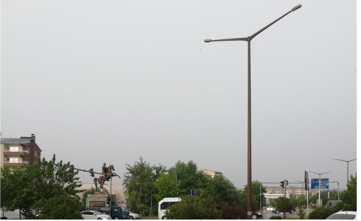
Şekil 3.3. Muş İstasyon Caddesi mevcut aydınlatma direği
