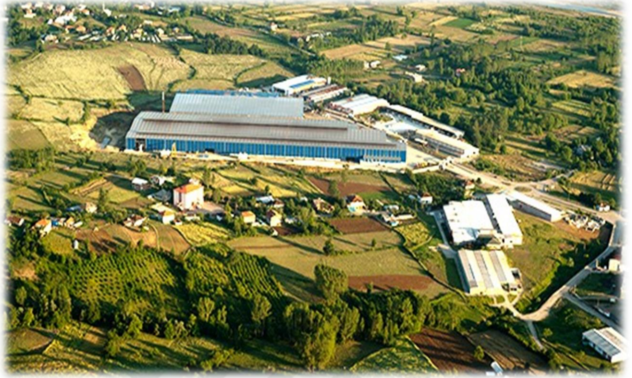
Resim 7: Bartın OSB Mevcut Durumu
