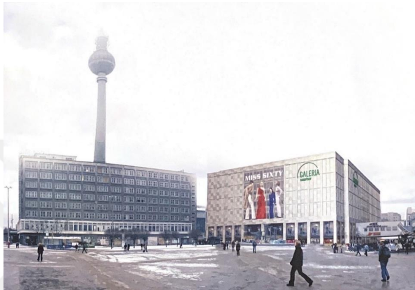
Figure 3.19: Galeria Kaufhof Alexanderplatz in Berlin, Germany
