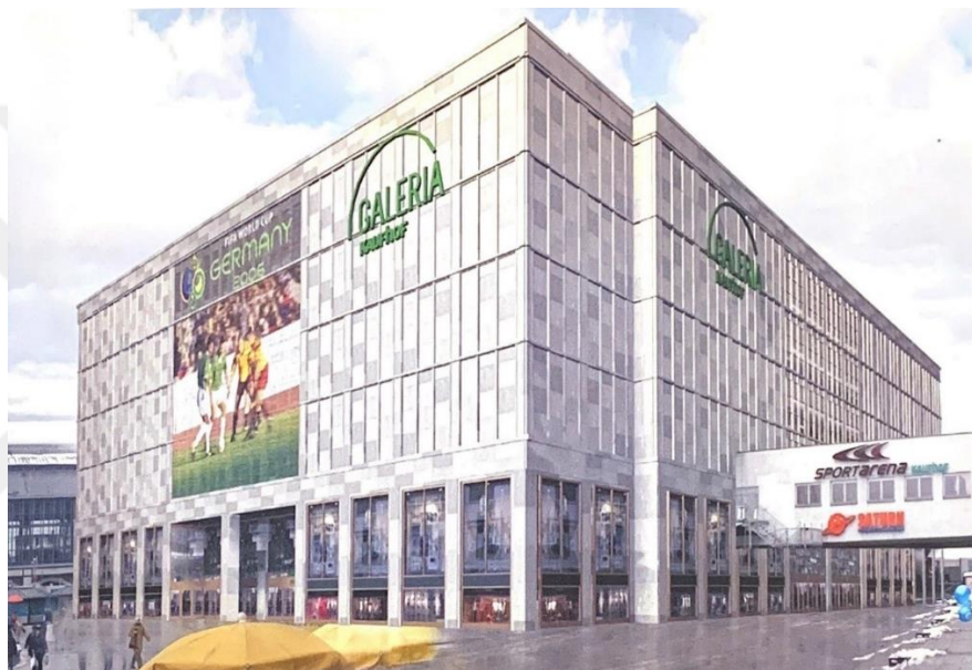
Figure 3.18: Galeria Kaufhof Alexanderplatz in Berlin, Germany
