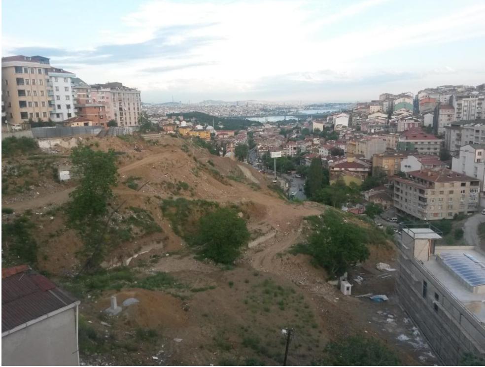
Foto 6: Gaziosmanpaşa’da en son yıkılan ve yapımına başlanan “We Haliç Kentsel Dönüşüm Proje Alanı”
