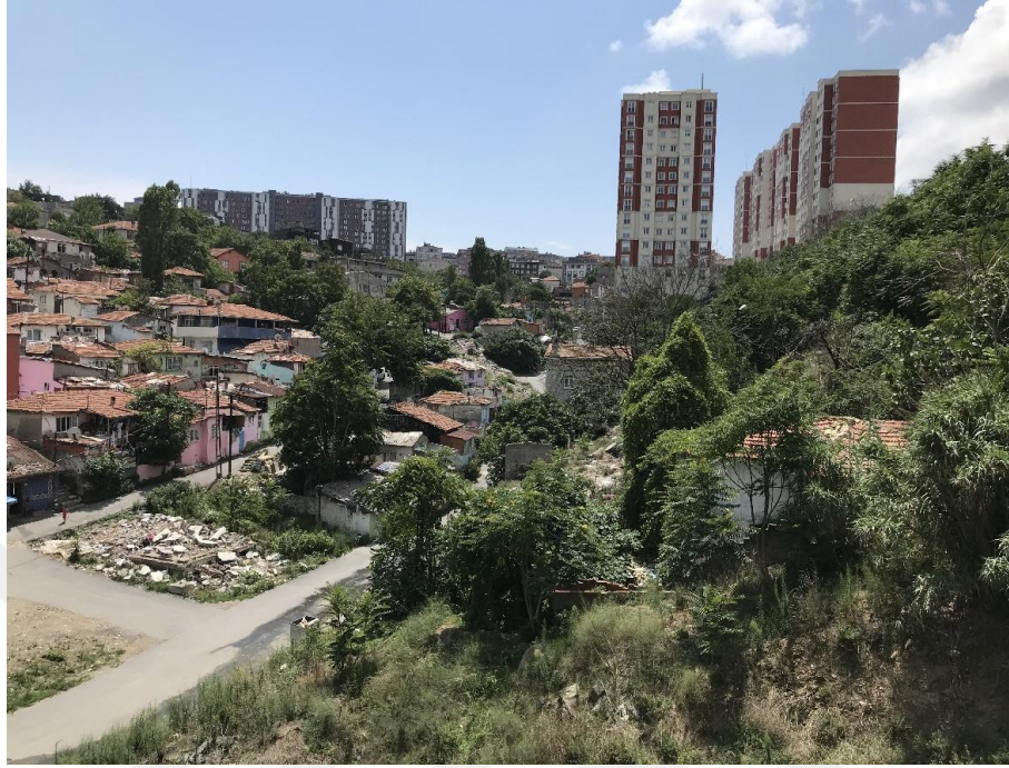
Foto 18: Sarıgöl Mahallesinde yeni yapılan ve yıkılmayı bekleyen konutlar bir arada bulunmaktadır.
