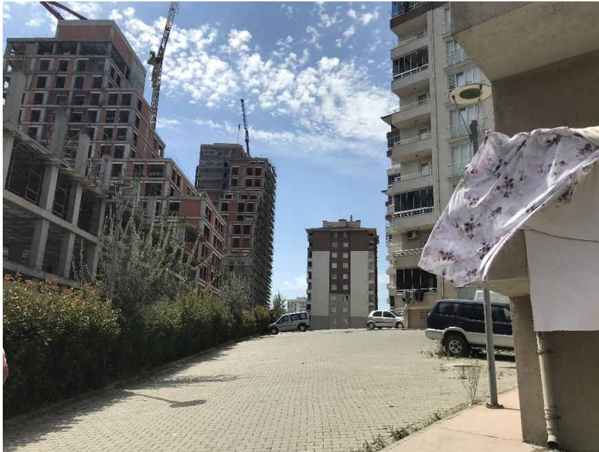
Foto 32: Konutlar içerisinde herhangi bir yeşil alan bulunmamaktadır. Hak sahiplerinin boşalttığı alanda ise lüks konutlar inşa edilmektedir.
