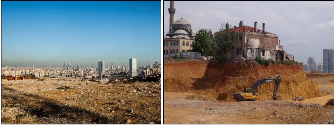
Foto 4-5: Fikirtepe Kentsel Dönüşüm Alanı. Yıkım sürecinde çokça gündeme gelen projede yıkılmadan kalan tek ev, projenin simgesi haline gelmiştir. Kaynak: http://megaprojeleristanbul.com
