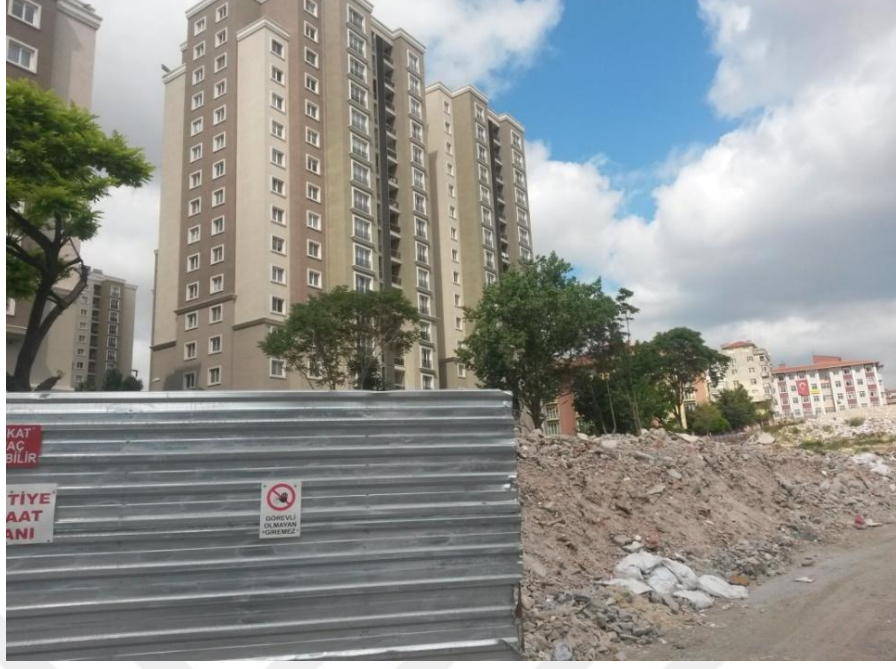
Foto 35: Yıkılan 2. Etap ve yapımı tamamlanmış Sahilpark Konutları bir arada bulunmaktadır.
