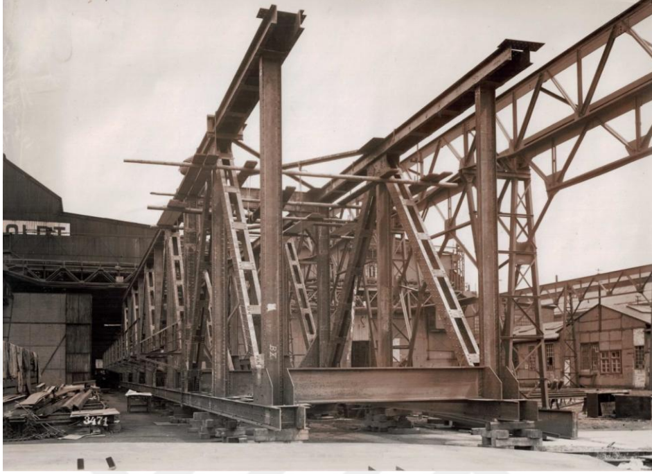
Resim I: Fabrikada yapımı sırasında Cambazkaya Köprüsü.
