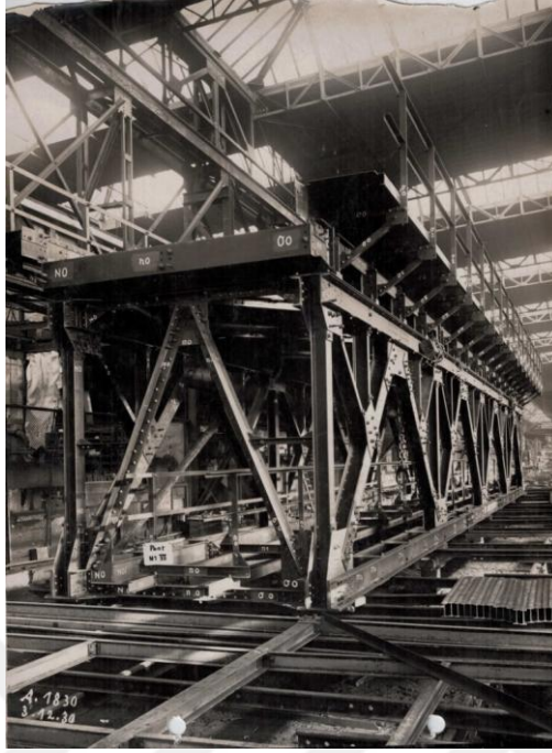
Resim IV: Fabrika da yapımı sırasında Bekdemir Köprü Parçası.
