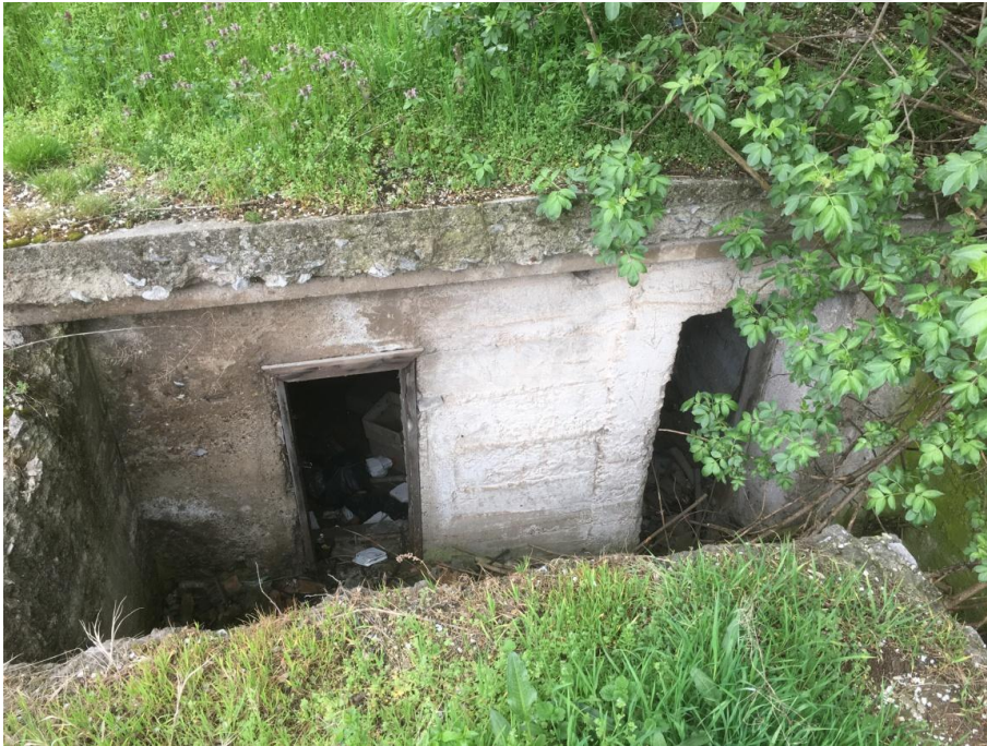
Ek XII- Resim XXVII: Bozüyük Demiryolu İstasyonu II. Dünya savaşı yıllarında inşa edilen sığınak.
