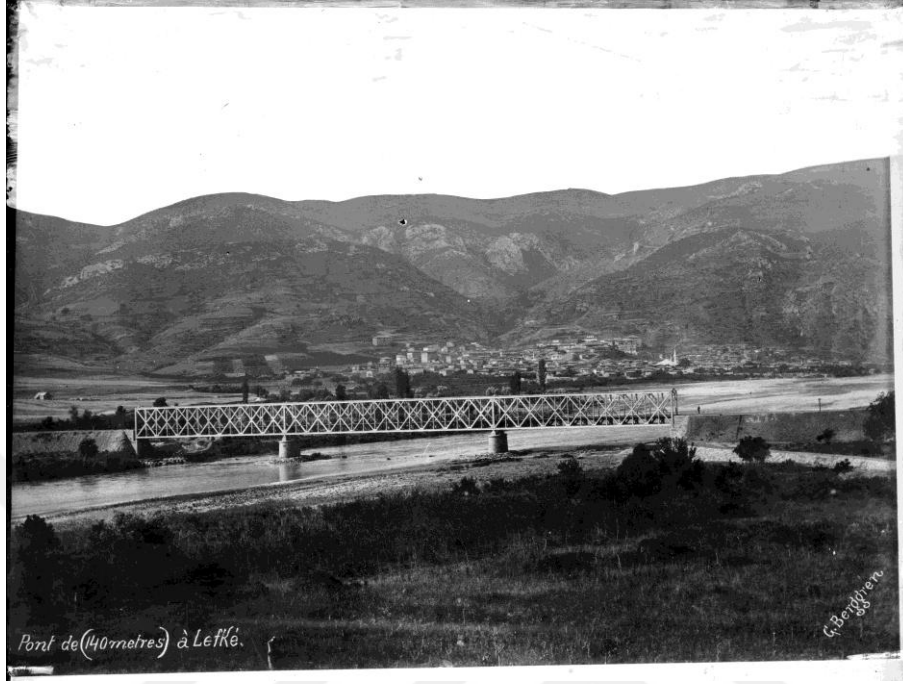
Resim II: Bilecik-Lefke Demiryolu Köprüsü.
