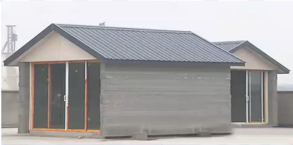
Şekil 2.3. Win Sun Şti. 3 boyutlu beton yazıcı kullanılarak yaptığı evler (yhbm, 2016).
