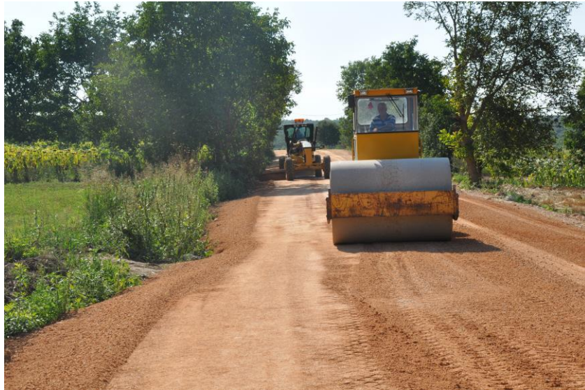
Şekil 5.19. Mermer atığı ile yapılan temel tabakasının sıkıştırılması
