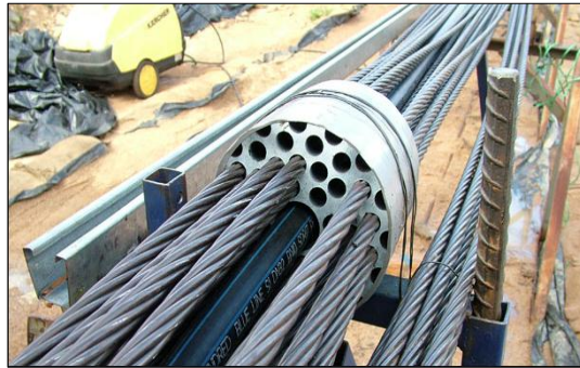
Şekil 2.5. Öngerme ankraji olarak kullanılan çelik halat.
