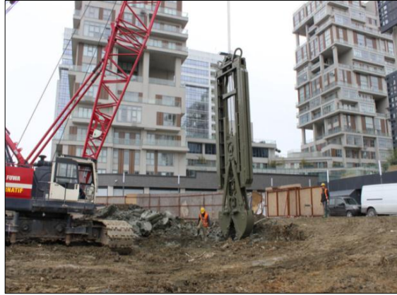
Şekil 2.3. Diyafram duvar kazı işlemi.
