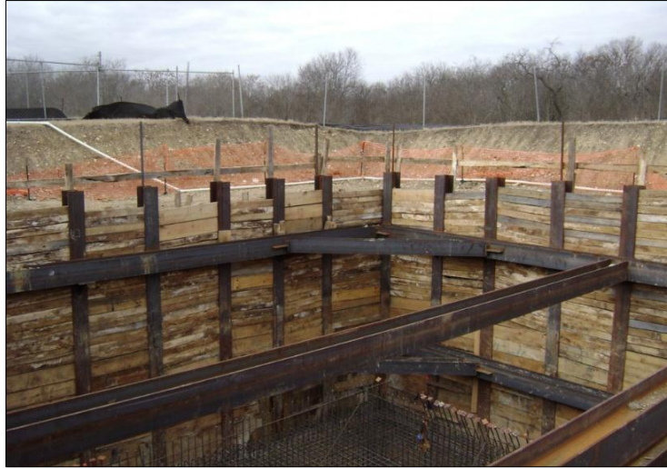
Şekil 2.12 Ahşap palplanş inşaatı.
