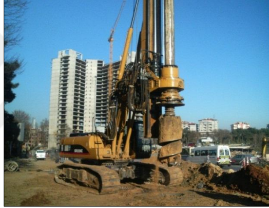
Şekil 2.1. Fore kazık delgi işlemi.
