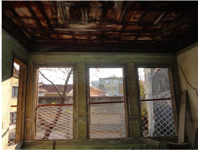
Şekil 5.3. Dikmeler ve çatı taşıyıcıları.
