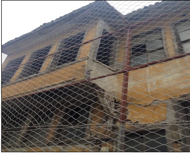
Şekil 5.1. Yapının önden görünüşü.
