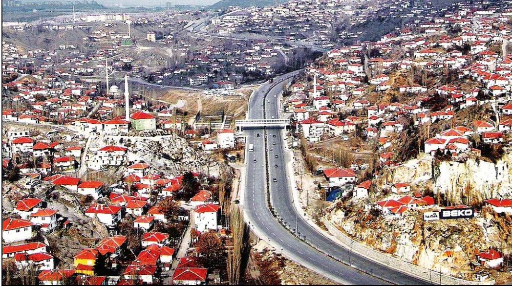
b. Protokol yolu ve çevresindeki gecekonduların görünümü
