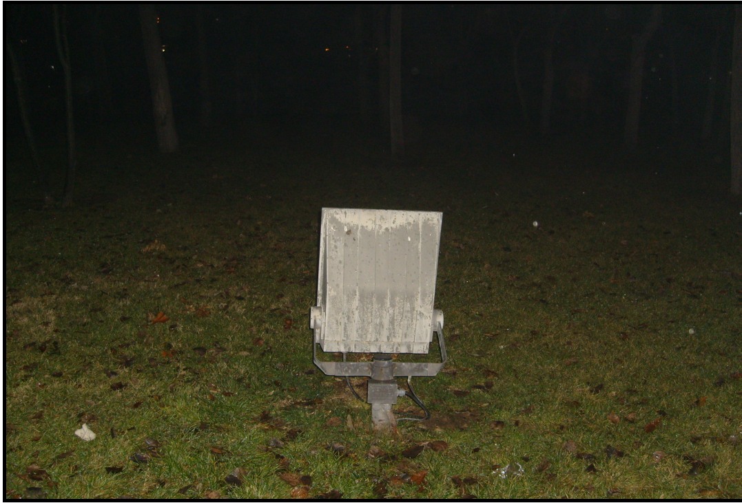
Şekil 5.7 Altınpark'ta bakımsızlık yüzünden deformasyona uğramış bir projektör örneği (Fotoğraf: Fatih Yenioğlu 2009).
