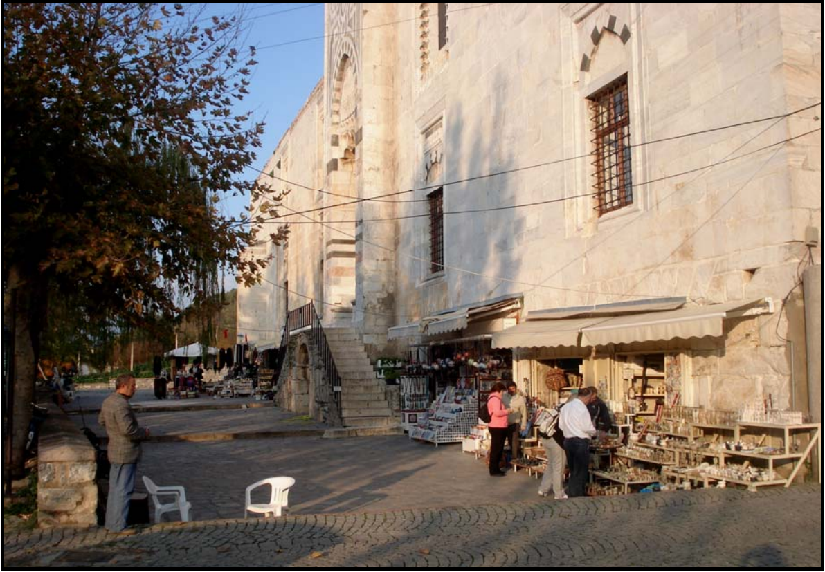
Şekil 4.24 İsa Bey Camii batı girişi (Fotoğraf: Gülşah Kaçmaz 2010).
