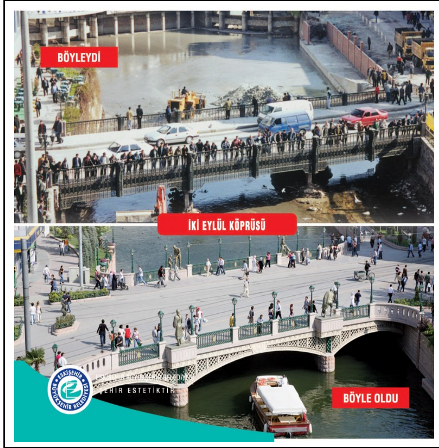
Şekil 4.41 İki Eylül Köprüsü eski ve yeni durumu (URL-8 2010).
