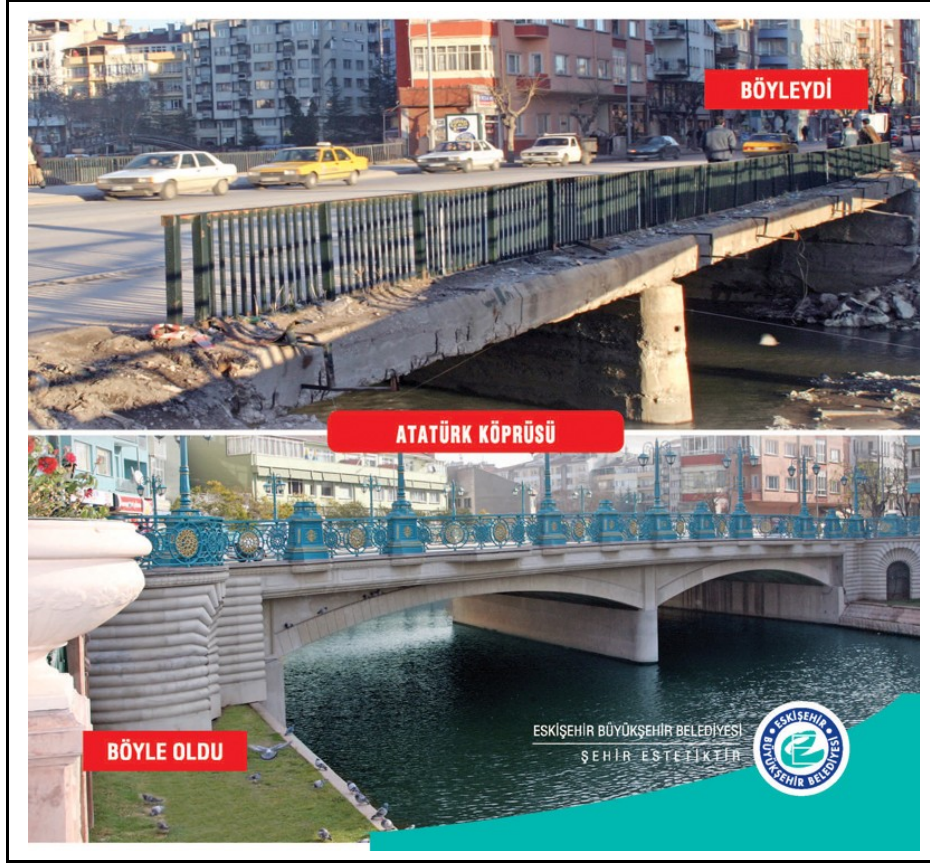
Şekil 4.42 Atatürk Köprüsü eski ve yeni durumu (URL-8 2010).
