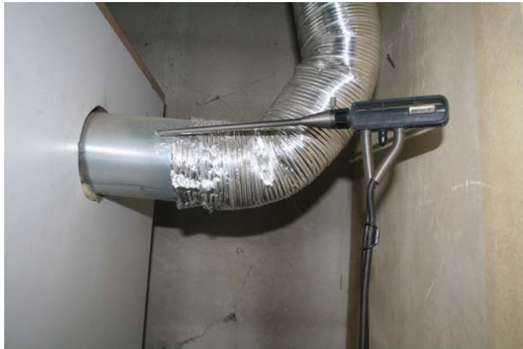
Şekil.3.25 Testo probunun bacadaki konumu.
